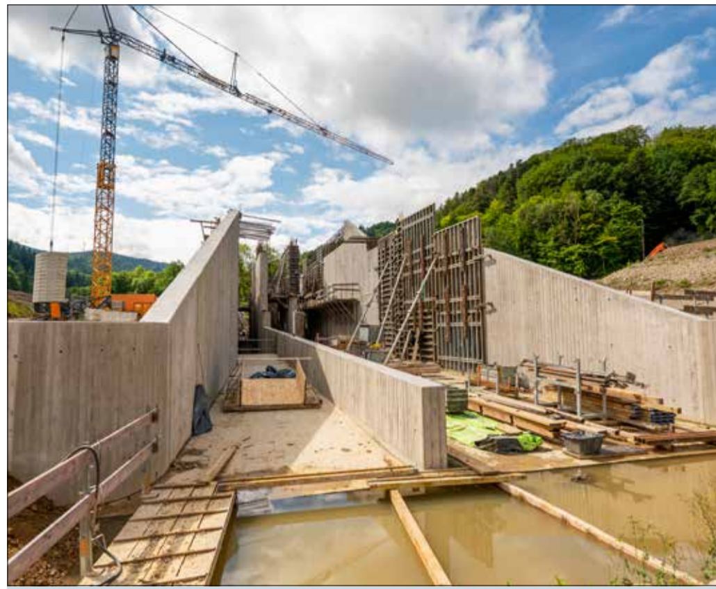
Bohrertal: Hochwasserschutz ist im Zeitplan
