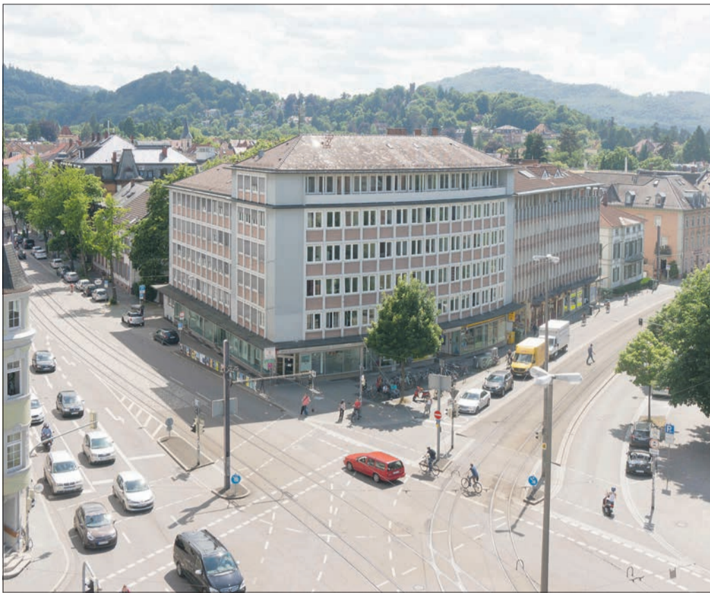
Erhalt, Umbau oder Abriss – das sind mögliche Varianten beim Verkauf des Bürgeramts in der Basler Straße. (Foto: A. J. Schmidt)
