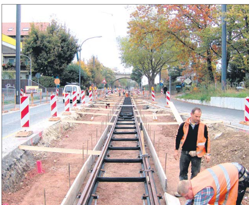
Kerzengerade durchs Nadelöhr: Im Bereich der Höllentalbahnbrücke (Bildmitte) und der Tankstelle (links) war ein planerischer Kunstgriff notwendig, um teuren Grunderwerb und einen Neubau der Bogenbrücke zu vermeiden: Stadtbahn und Kraftverkehr teilen sich den Straßenraum (Foto: A. Lechler)
