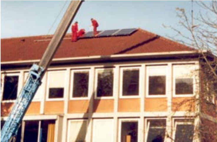
Abb. 12: Installation der PV-Anlage auf dem Berthold-Gymnasium
