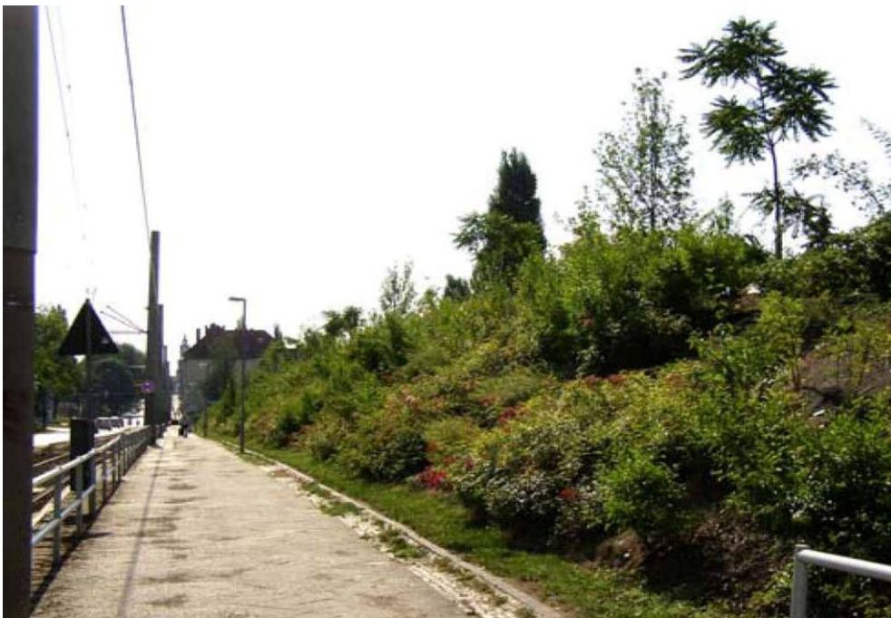
Abb. 104: oben - Abbrucharbeiten / unten - begrünter Lärmschutzwall nach Gebäudeabriss (Seelmann Landschaftsarchitekten)
