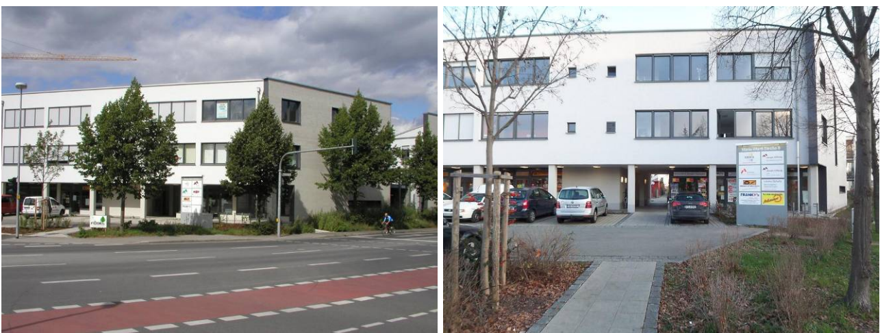
Abb. 28: links – Gewerbeimmobilie am lärmbelasteten Standort / rechts – Geschäfte und Büros ergänzen die Wohnnutzung funktional. (Joseph-Stiftung)
