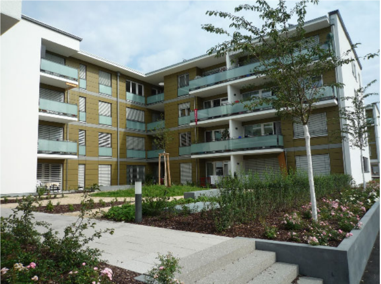
Abb. 54: Hofsituation (Franz und Geyer Architekten)
