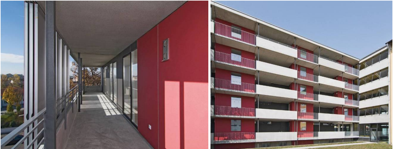
Abb. 67: links – Laubengang an der verlärmten Gebäudeseite mit Schiebeläden / rechts - Innenhofsituation mit Laubengängen und Loggien (Dokumentation Deutscher Bauherrenpreis 2010)
