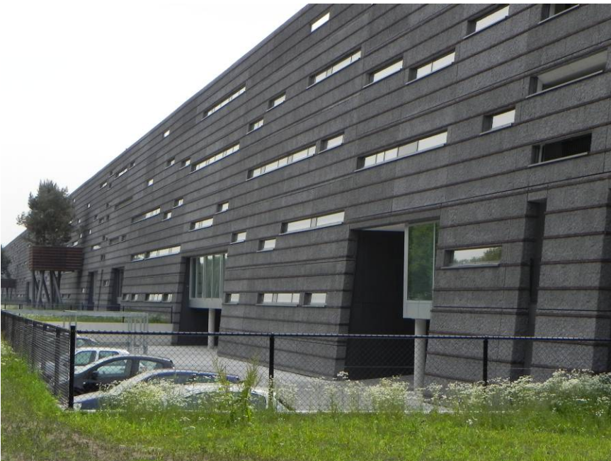
Abb. 46: Parkplatz zur Autobahn orientiert (PRR)
