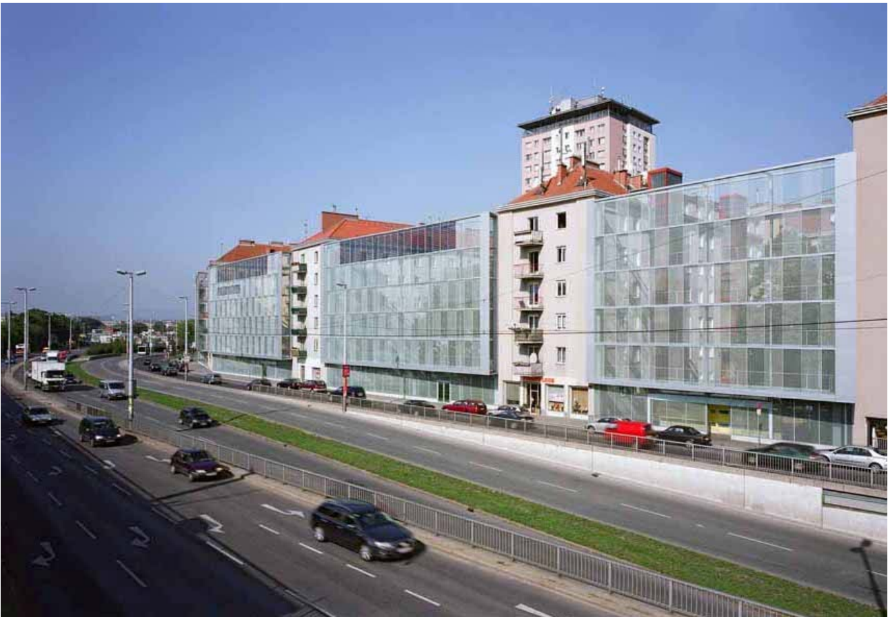
Abb. 69: Lärmschutzwand am Theodor-Körner-Hof (TREUSCH achitecture ZT GmbH)
