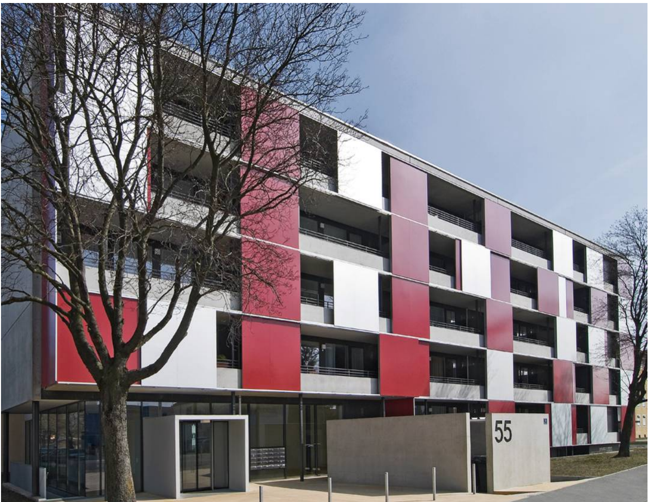
Abb. 68: Gebäudeansicht von der Nürnberger Straße mit den markanten Schiebeelementen (Dokumentation Deutscher Bauherrenpreis 2010)
