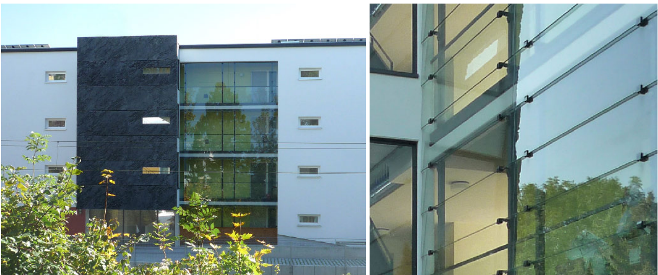
Abb. 53: links – Fassade Nordwest / rechts – Schuppenverglasung zur Bahnanlage (Franz und Geyer Architekten)
