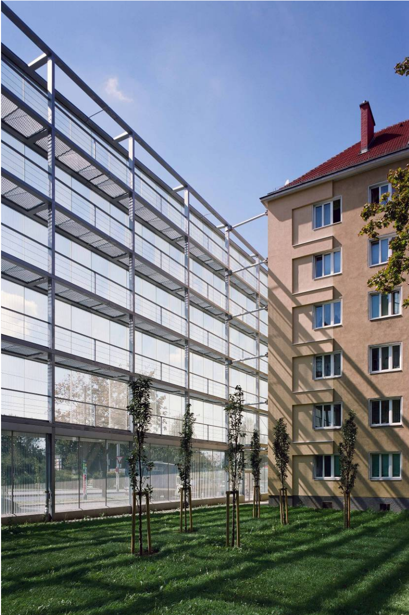
Abb. 72: Lärmschutzwand hofseitig (TREUSCH architecture ZT GmbH)
