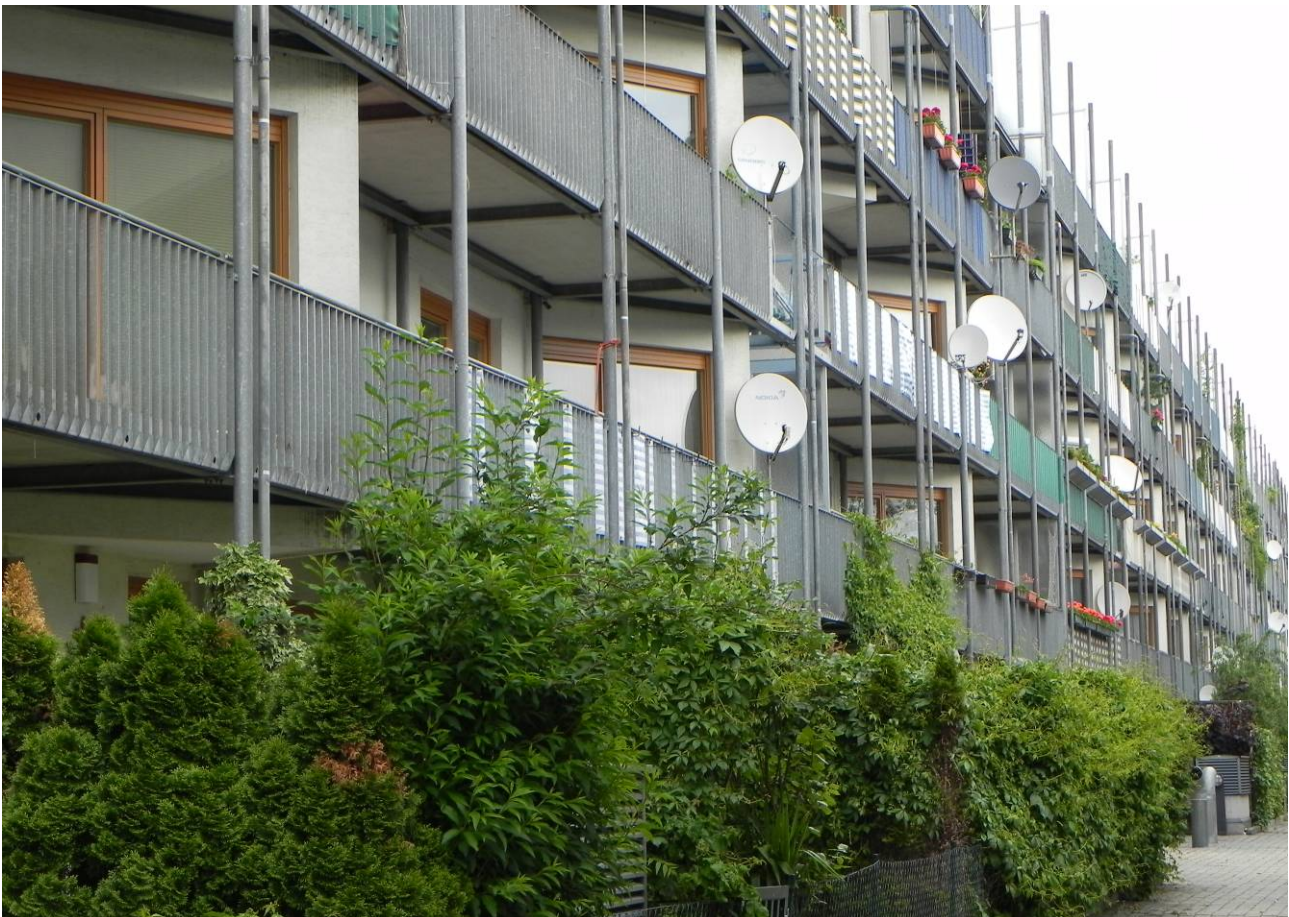
Abb. 42: Loggien zur straßenabgewandten Seite (PRR)
