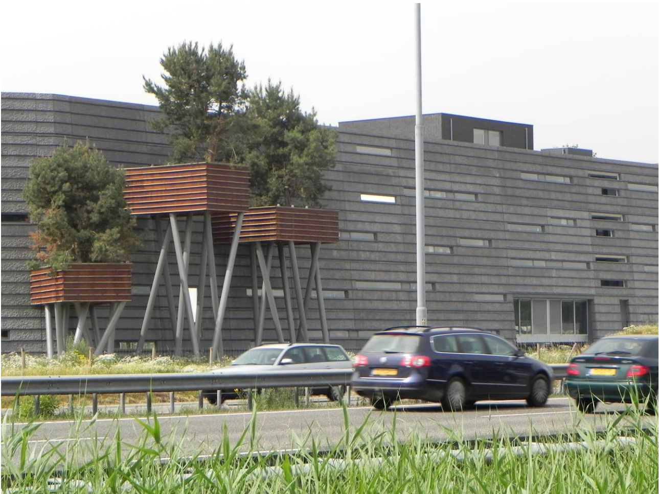
Abb. 44: bewohnte Lärmschutzwand an der A 58 (PRR)
