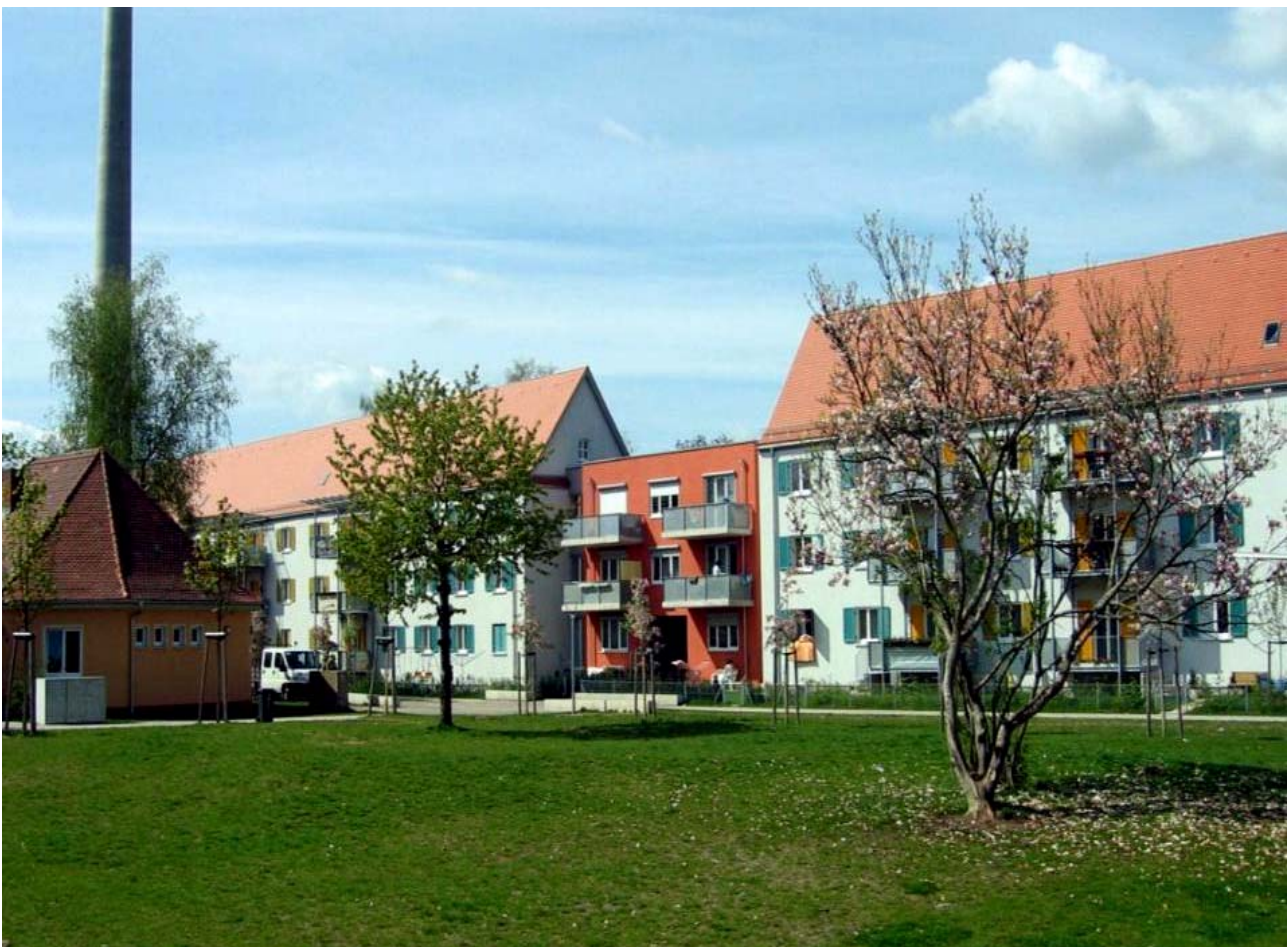
Abb. 94: Ansicht der Hofseite des Lückenschlusses (B + B Architekten, Hohenwart)
