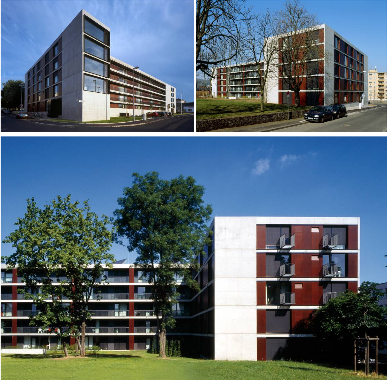
Abb. 59: Straßenseitig wurden Laubengänge und Gemeinschaftsräume angeordnet. Die besonders lärmempfindlichen Schlaf- und Studierzimmer liegen auf der vom Baukörper beruhigten Grundstücksseite. (Dokumentation Deutscher Bauherrenpreis 2010)
