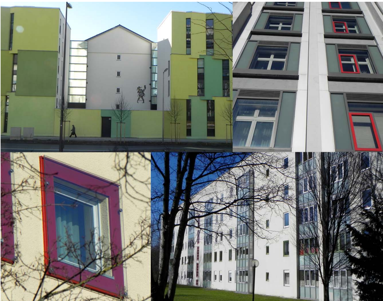
Abb. 11: Lärmbaukasten am Mittleren Ring (PRR)
