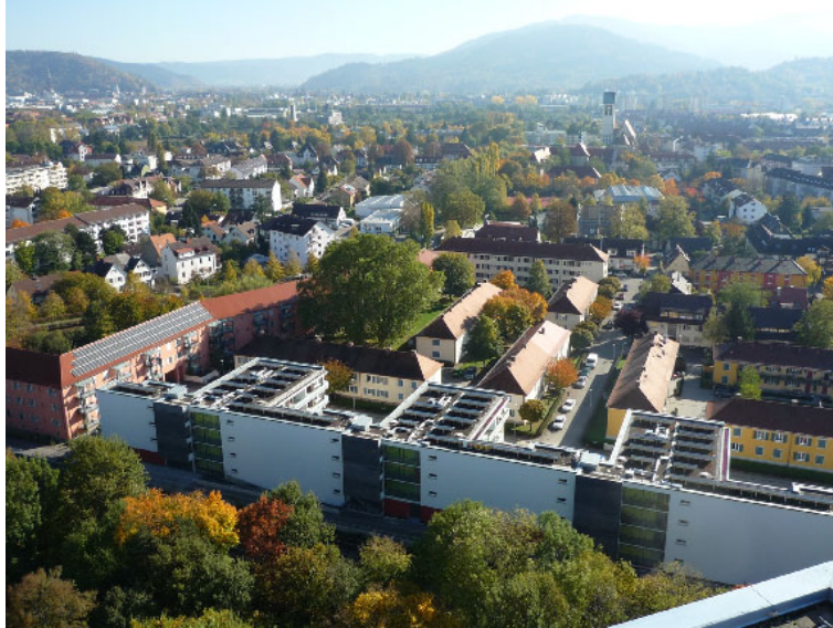
Abb. 52: Bebauung Laubenweg (Franz und Geyer Architekten)
