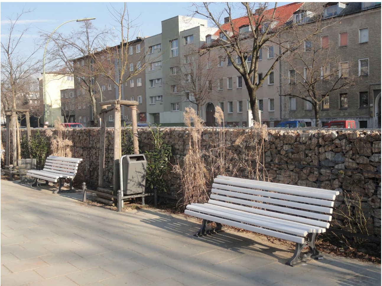
Abb. 107: Einsatz von Gabionenwänden als Lärmschutz und Begrenzung auf dem Nauener Platz (PRR)
