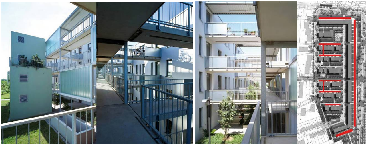
Abb. 38: Die Laubengangerschließung (im Plan rechts rot markiert) bietet Lärmschutz und einen barrierefreien Wohnungszugang. (Dokumentation Deutscher Bauherrenpreis 2010)
