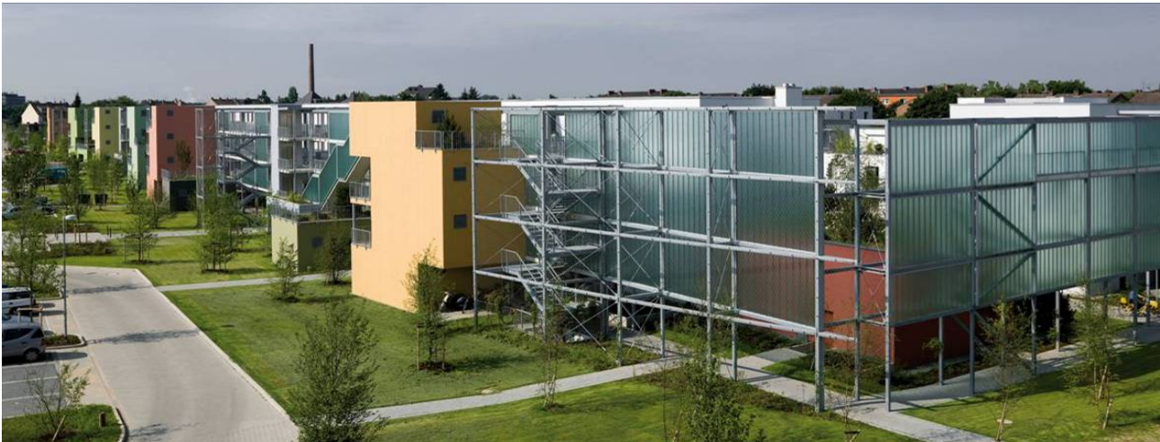
Abb. 37: Schallschutzwirkung durch Erschließungsbauwerke (Agirbas / Wienstroer)
