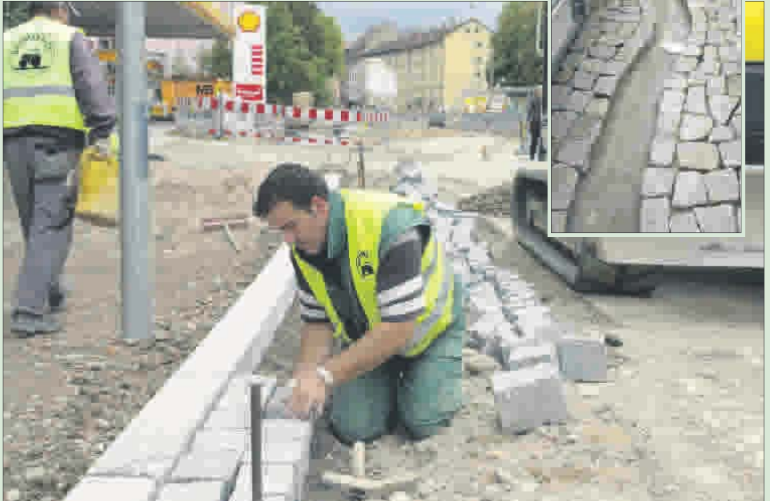
Südlich der Okenstraße sind schon die ersten Teile der „neuen“ Habsburgerstraße fertig. Auch der Glasbach (kleines Bild) hat ein neues, mit Natursteinen verkleidetes Bett bekommen. Es ist nicht nur hübscher, sondern auch leistungsfähiger: Erst ab 5 Kubikmeter pro Sekunde ist künftig mit Überschwemmungen zu rechnen. Statistisch gesehen ist das aber nur einmal in 100 Jahren der Fall. (Fotos: R. Buhl)
