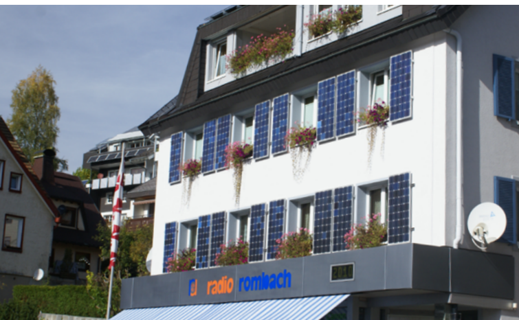
Solarfassade bei Radio Rombach in Schonach (Bild: Energieagentur Regio Freiburg)
