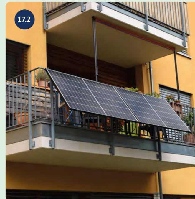
Kleine Balkone an Mietwohnungen bieten sich als Einstieg in die Selbstversorgung an. Quelle: BuGG
