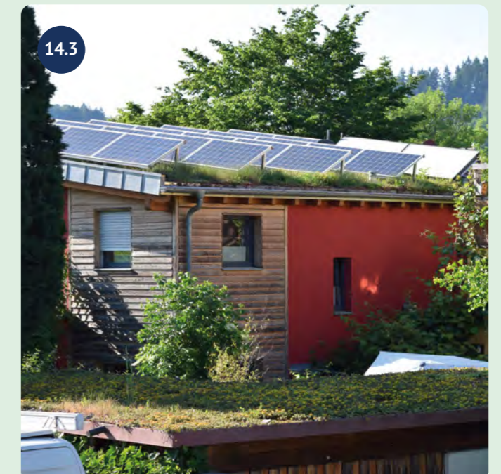
Das Grün unter den PV-Modulen kühlt die Anlage, steigert die Leistung und schützt die Dachabdichtung. Das machen sich auch diese Hauseigentümer im Stadtteil Waldsee zunutze. Quelle: BuGG
