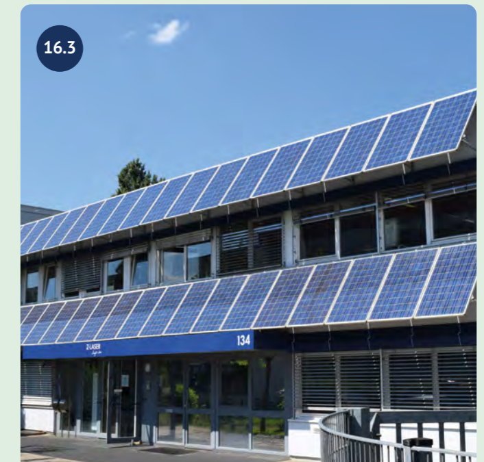
Energiegewinnung an einem Gewerbegebäude in der Merzhauser Straße. Quelle: BuGG
