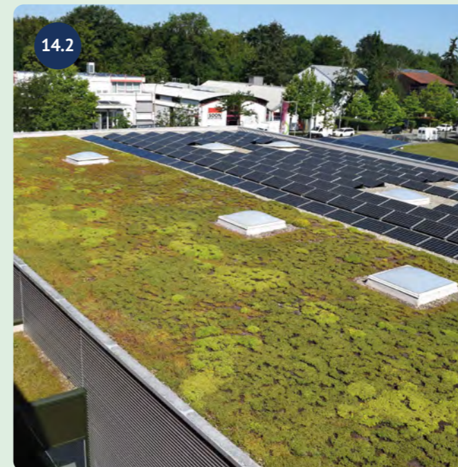
Flachdächer bieten ein riesiges Potential sowohl für Grünflächen als auch für Strom- oder Wärmeenergiegewinnung. Auf dem Solarcampus wird jeder Quadratmeter genutzt. Quelle: BuGG
