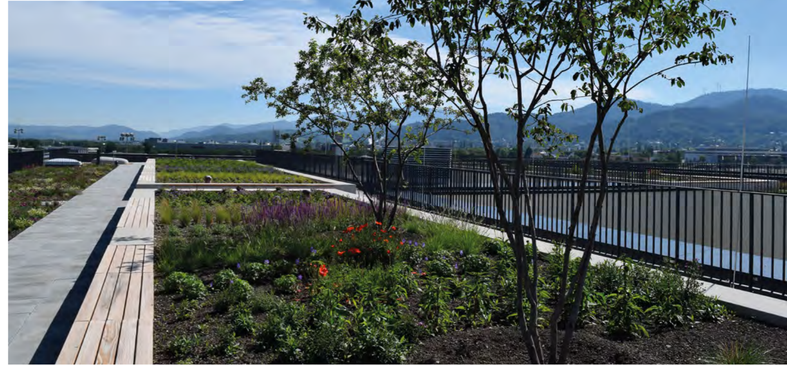
Die Dächer des neuen Fraunhofer Instituts beherbergen auch intensiv begrünte Flächen mit Stauden und Gehölzen. Quelle: BuGG
