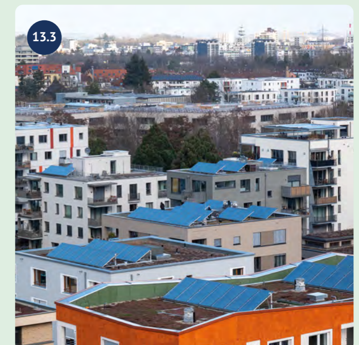
Solarthermie mit extensiver Dachbegrünung auf den Dächern im Wohngebiet Gutleutmatten in Freiburg. Quelle: Stadt Freiburg
