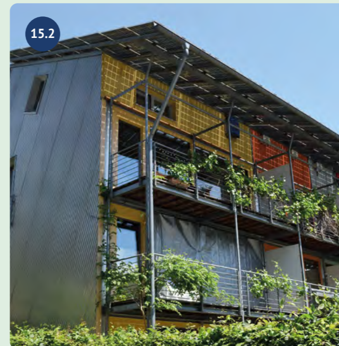
Diese PV-Balkon-Überdachung in der Merzhauser Straße schützt vor Sonne und Regen wie ein herkömmliches Dach. Die Stromerzeugung ist ein zusätzlicher Vorteil. Quelle: BuGG
