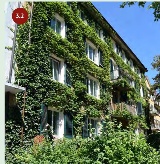
Efeu und Wilder Wein an einem Wohnhaus in der Zähringerstraße. Quelle: BuGG
