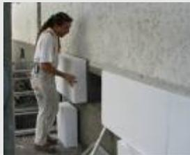
20 cm Wärmedämmverbundsystem
