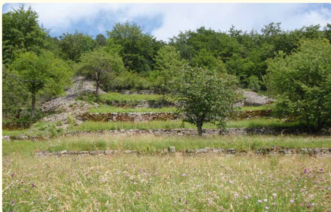
Trockenmauern in der freien Landschaft gehören zu den gesetzlich geschützten Biotopen in Baden-Württemberg.
