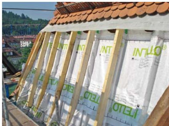
Die Holzkonstruktion kann in zwei Lagen mit einem weichen Dämmstoff (z.B. Mineralwolle, B1, WLZ 032 - 035) ausgedämmt werden. Unterhalb der aufgedoppelten und gedämmten Dachkonstruktion sollte eine Dampfbremse eingebaut werden, deren Dichtheit gegenüber Wasserdampf in Abhängigkeit von der vorhandenen Unterspannbahn gewählt werden muss.
