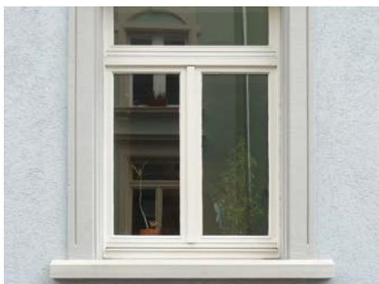
Glasrandverbund zu ersetzen oder den Einbau von Isolierglas in die alte Konstruktion zu prüfen. Beim Einbau der Fenster ist zu beachten, dass die Anschlüsse zum Mauerwerk luft- und winddicht ausgeführt werden. Fenster verbessern zusätzlich zur Energieeinsparung die Behaglichkeit im Gebäude durch die höheren Innenscheibentemperaturen. Bei Baudenkmalern geht die Reparatur von historischen Fenstern vor Fensterersatz. Auf jeden Fall ist die Genehmigungsfähigkeit vorab zu prüfen.
