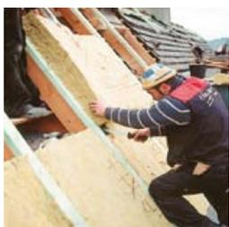
Zwischensparrendämmung mit aufgedoppelten Sparren von innen und von außen
