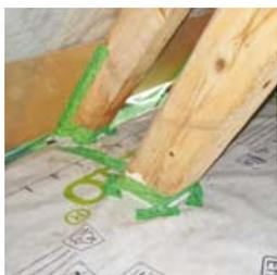
Insbesondere bei Übergängen zwischen Bauteilen ist auf die Dichtigkeit der Gebäudehülle zu achten.
