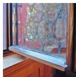
Überarbeiten einer einfachverglasten Bleiverglasung durch außenseitiges Aufdoppeln einer Isolierverglasung in Verbindung mit einer Be- und Entlüftungsanlage. Obere Gerichtslaube
