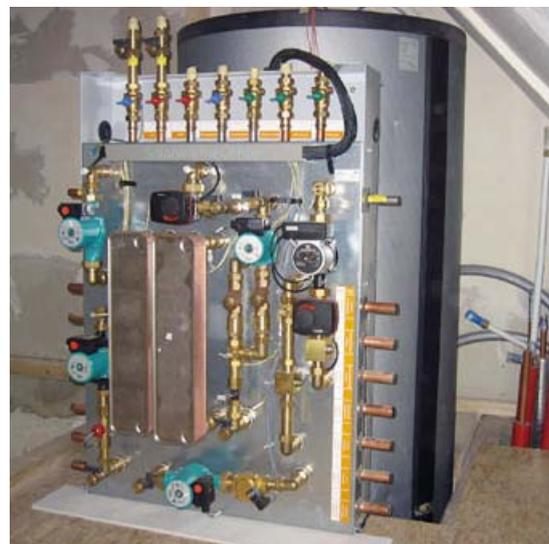
Frischwasserstation mit Platten-Wärmetauscher für Warmwasser
