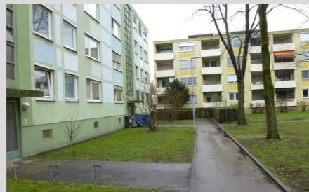
Abbildung 43: Gebäude vor der Sanierung Quelle: Stadt Freiburg
