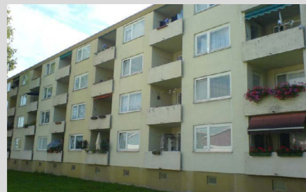
Abbildung 30: Binzengrün 11-15 vor Sanierung Quelle: Stadt Freiburg
