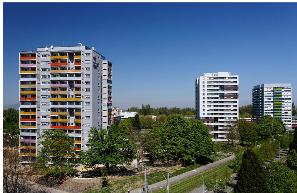
Abbildung 29: Die drei Passivhochhäuser Bugginger Straße 2, Binzengrün 9 und Bugginger Straße 50 Quelle: © MiguelBabo/Photography
