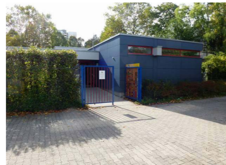
Abbildung 94: Kita nach der Modernisierung Quelle: Stadt Freiburg
