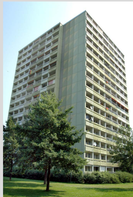
Abbildung 34: „Buggi 50“ vor der Sanierung Quelle: Stadt Freiburg
