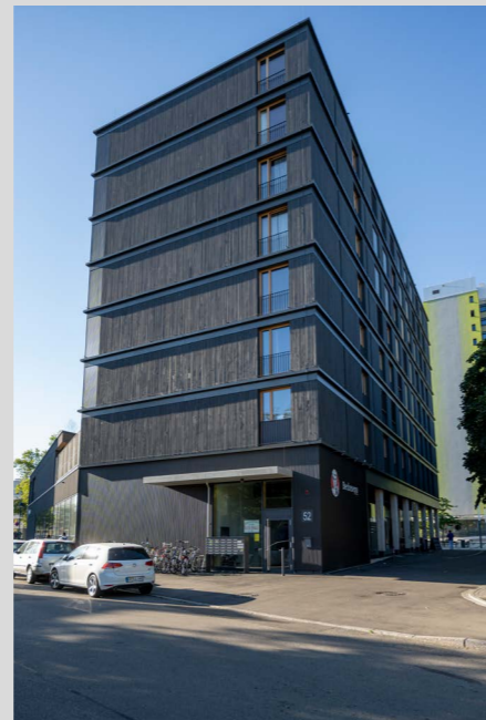
Abbildung 70: „Buggi 52“ in Holzbauweise
