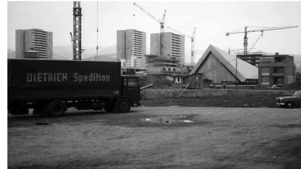
Abbildung 2: Weingarten in den 60er Jahren in der Bauzeit
