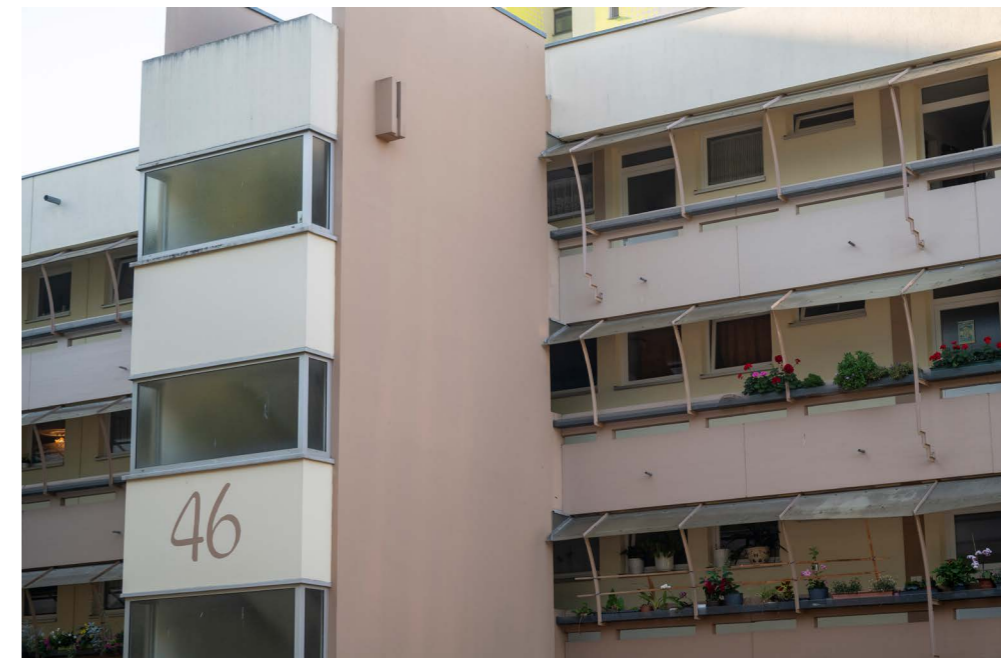
Abbildung 57: Treppenhaus und Laubengänge der Bugginger Straße 46 Quelle: Stadt Freiburg
