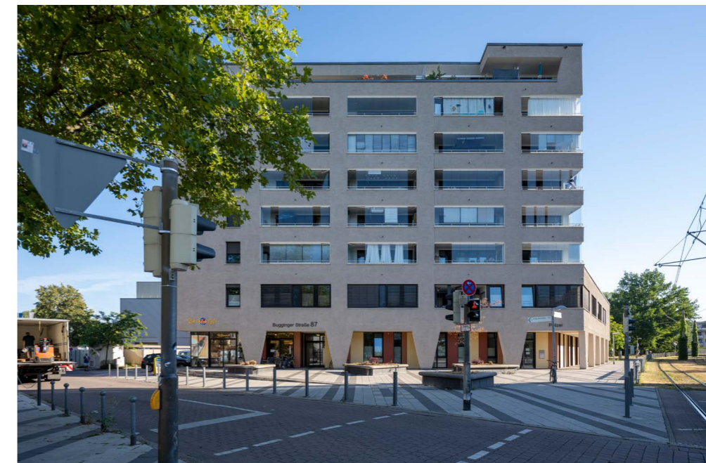
Abbildung 65: Der Neubau in der Bugginger Straße 87 als Teil der „Neuen Mitte“ Weingartens Quelle: Stadt Freiburg
