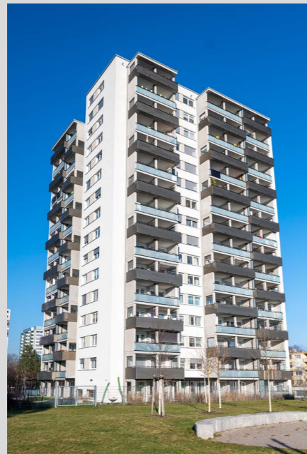
Abbildung 58: Binzengrün 34 nach Sanierung Quelle: Stadt Freiburg
