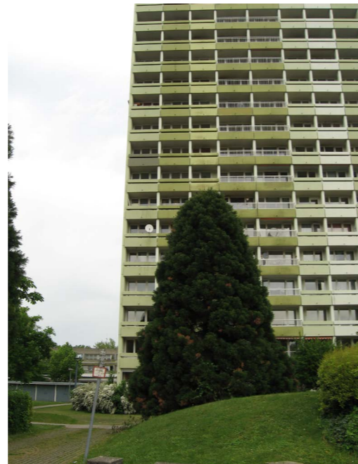
Abbildung 37: Ehemals triste Fassade „Buggi 50“ Quelle: Stadt Freiburg
