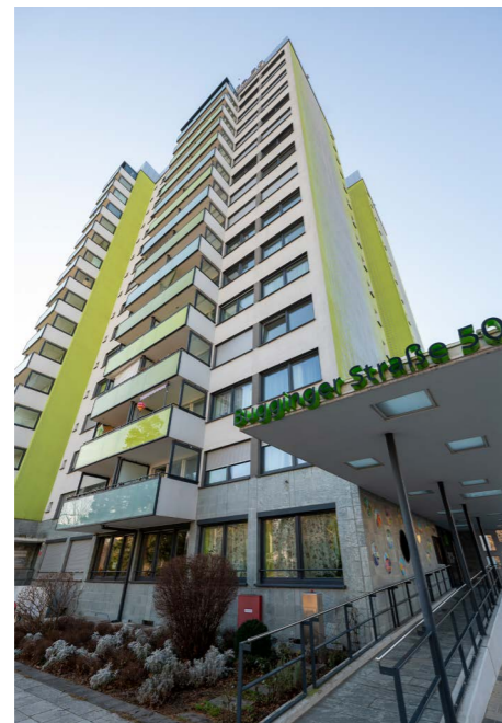
Abbildung 36: Barrierefreier Aufgang „Buggi 50“ Quelle: Stadt Freiburg
