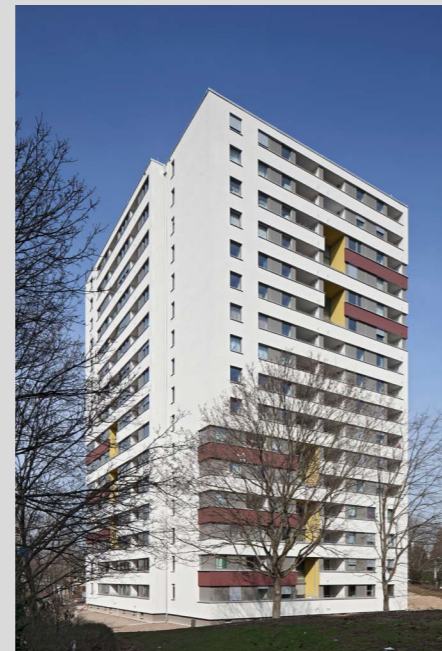
Abbildung 40: Binzengrün 9 nach Sanierung Quelle: M. Löffelhardt | a-a-k.com
