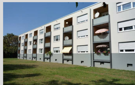
Abbildung 31: Saniertes Binzengrün 11-15 Quelle: Stadt Freiburg
