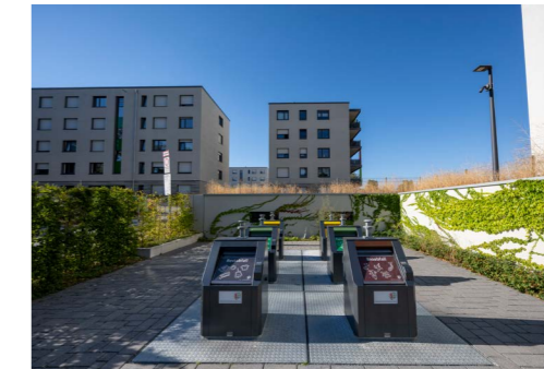
Abbildung 27: Moderne Müllentsorgungsanlage Quelle: Stadt Freiburg
