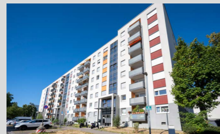
Abbildung 49: Neugestalteter Zeilenbau Quelle: Stadt Freiburg
