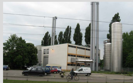
Abbildung 62: Heizkraftwerk am Gebietsrand Quelle: Stadt Freiburg
