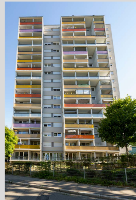
Abbildung 54: Sanierte Bugginger Straße 2 Quelle: Stadt Freiburg
