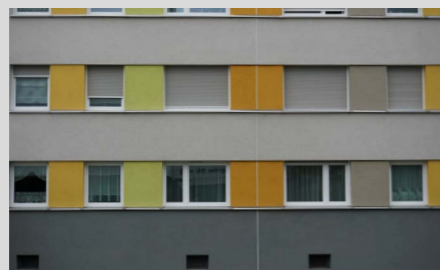
Abbildung 44: Farbenfrohe Fassaden Quelle: KommunalKonzept BW GmbH
