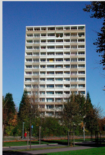
Abbildung 39: Binzengrün 9 vor der Sanierung Quelle: Freiburger Stadtbau GmbH
