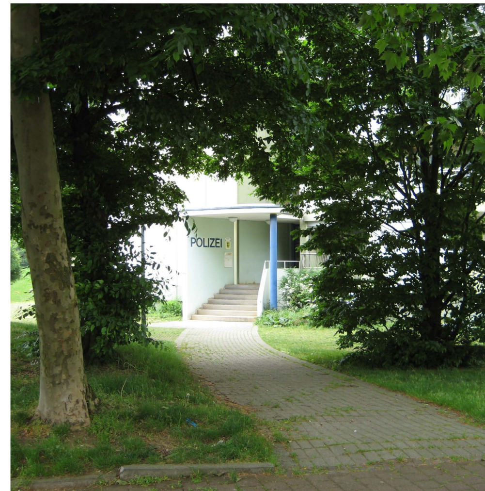
Abbildung 28: Dichter Bewuchs auf der Zuwegung zur Polizeidienststelle vor der Sanierung Quelle: Stadt Freiburg
