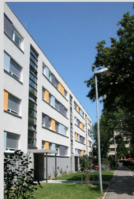
Abbildung 32: Sanierte Bugginger Straße 1-7 Quelle: Freiburger Stadtbau GmbH
