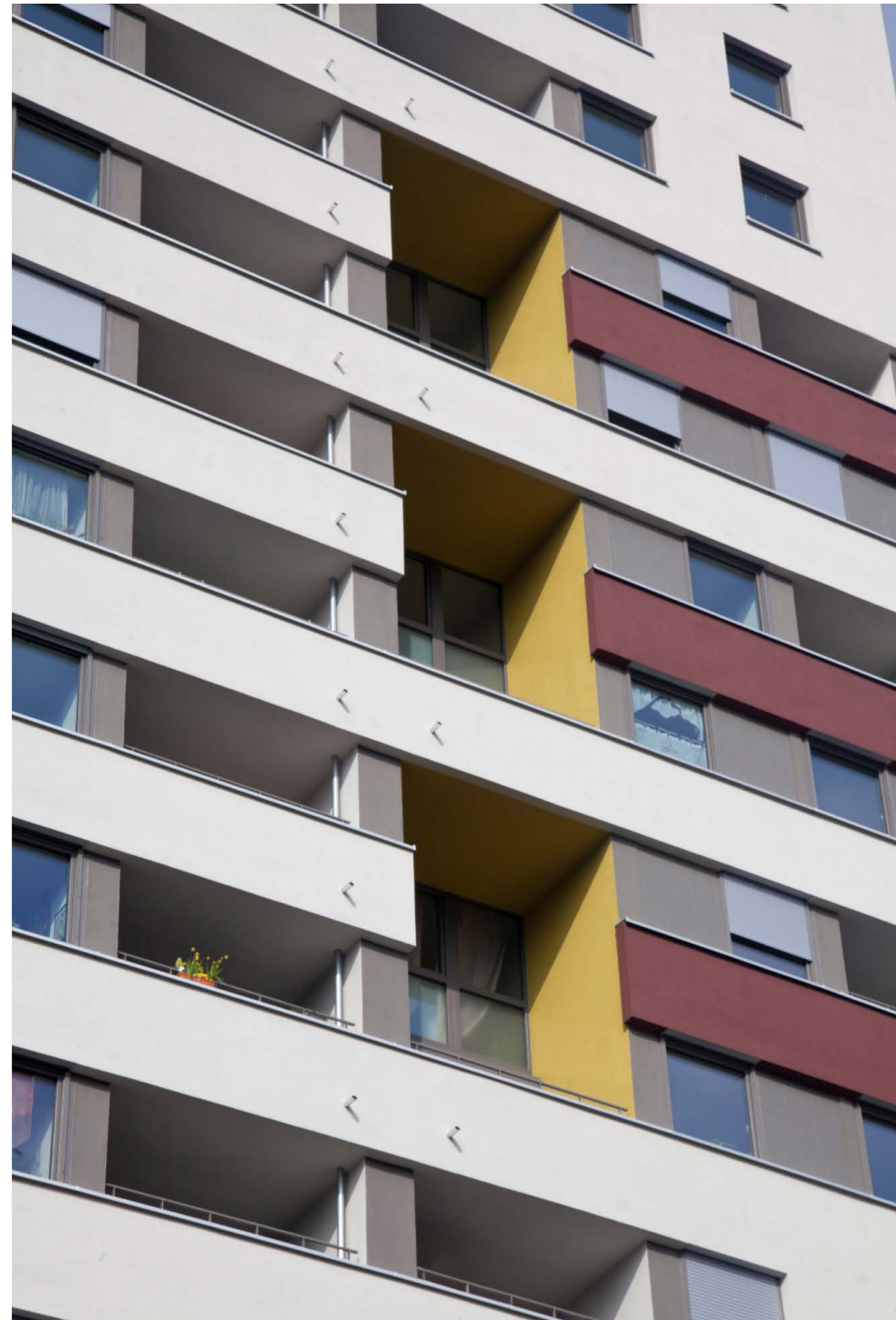
Abbildung 42: Markante Fassade des Hochhauses Binzengrün 9
