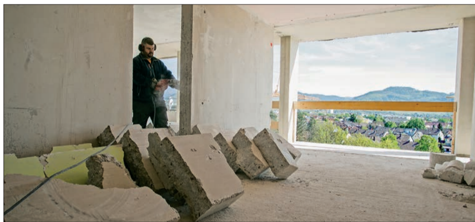
Alles muss raus: Bei der Sanierung im Binzengrün 34 geht es ans Eingemachte.
