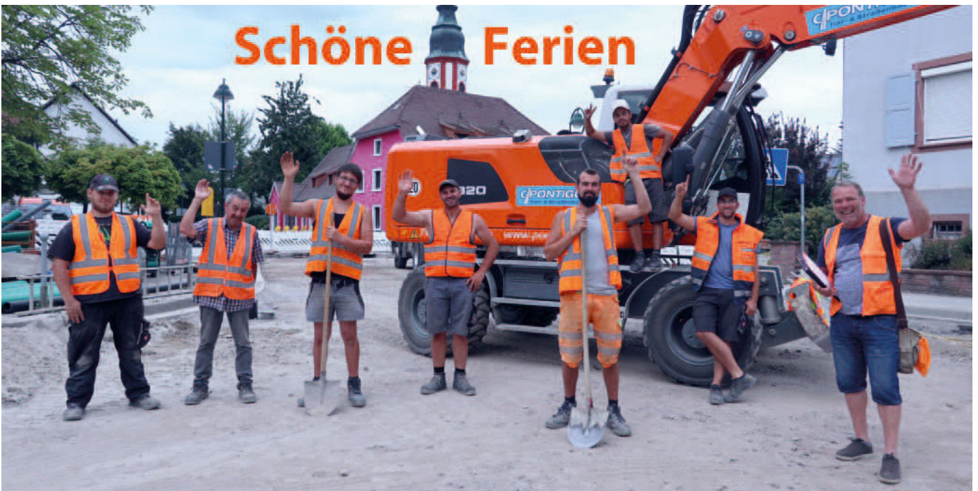
Sie haben gut geschafft. Jetzt geht es in die Bauferien.
