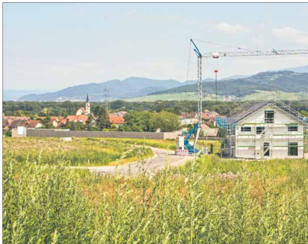
Fernseher unnötig: Tiengen bietet wunderschöne Ausblicke über Freiburg in den Schwarzwald – zum Beispiel vom neuen Baugebiet Sechzehn Jauchert aus. (Foto: A. J. Schmidt)
