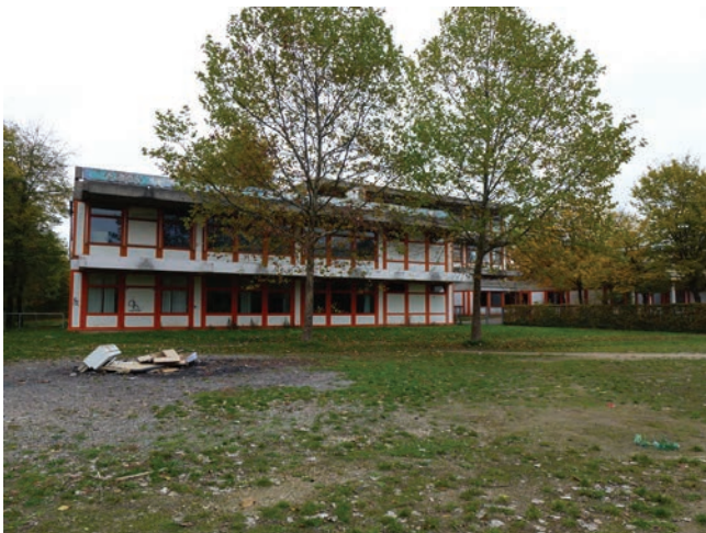
Haus Weingarten, ehemaliges Schulgebäude mit Brachfläche
