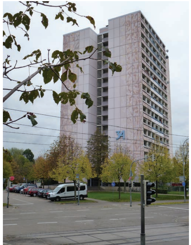
Hochhaus Binzengrün 34 vor der Sanierung
