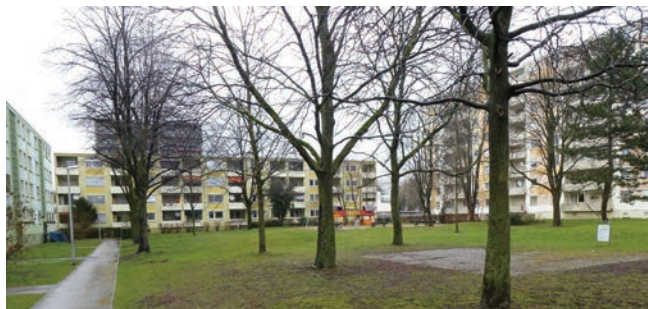
typische Hofsituation mit vier- und achtgeschossigen Wohngebäuden
