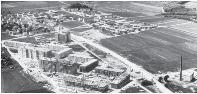
Sulzburger Straße im Bau
