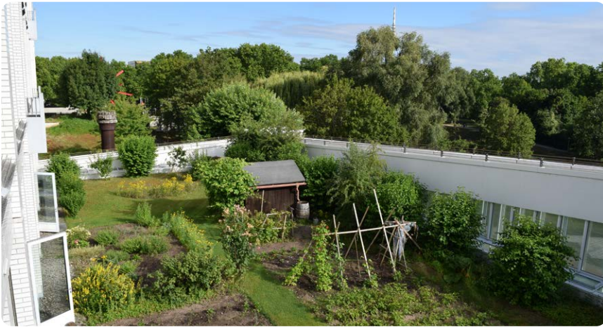
Eine Intensivbegrünung in Mannheim: Das Dach bietet nicht nur Platz für Bäume und Sträucher, sondern auch für einen Dachgarten mit Obst und Gemüse.
