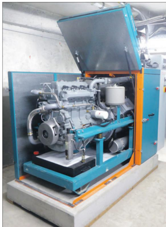
**Jetzt wird's laut:** Im Keller des Altbaus der Pestalozzischule hört man es rumpeln. Das neue Blockheizkraftwerk, das gleich vier Gebäude mit Strom und warmem Wasser versorgt, hat deutlich Dampf im Kessel. (Foto: B. Wiese)
