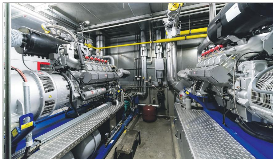
**Maschinen(t)raum:** Im Keller des Stadttheaters stehen drei jeweils knapp 500 PS starke V-Zwölfzylinder-Motoren. Sie produzieren aus Biomethan Strom. Die dabei entstehende Wärme reicht aus, um 70 Prozent des jährlichen Wärmebedarfs im Innenstadt-Fernwärmenetz zu decken. Durch die Nutzung der Abwärme (Kraft-Wärme-Kopplung) liegt der Wirkungsgrad bei rund 95 Prozent – mehr als doppelt so viel wie in konventionellen Kraftwerken. (Foto: B. Bender)
