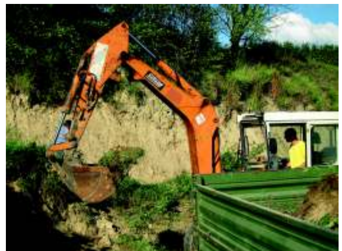
Andreas und Norbert Dangel bei Baggerarbeiten an der Lössböschung
