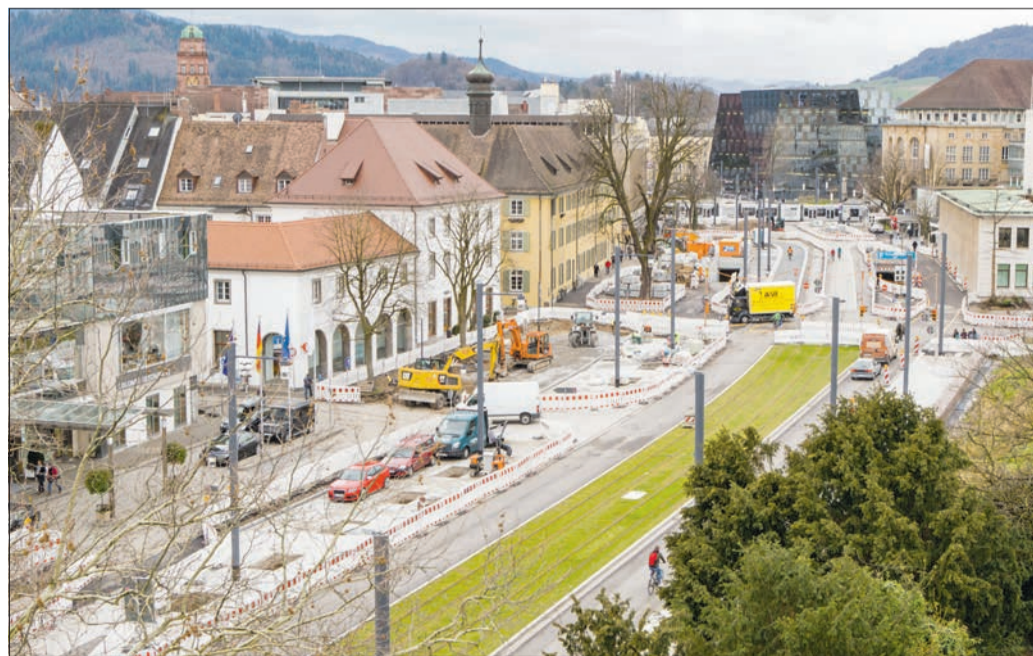
Ende in Sicht: Die Vogelperspektive zeigt, dass sich hinter Bauzäunen mächtig was getan hat im Rotteckring. Der Bereich vor dem Colombipark wird noch im Mai fertig. (Foto: A. J. Schmidt)
