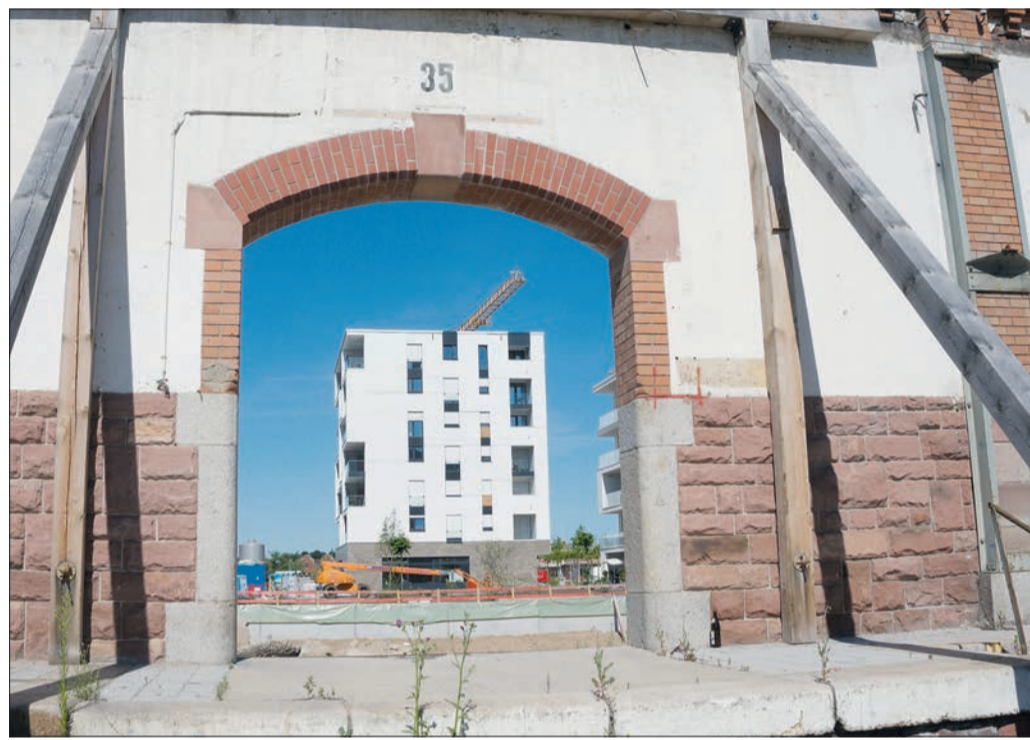
Auch verstärkter Wohnungsbau , wie hier auf dem Güterbahndareal, konnte die Preissteigerung nicht bremsen. (Foto: A. J. Schmidt)
