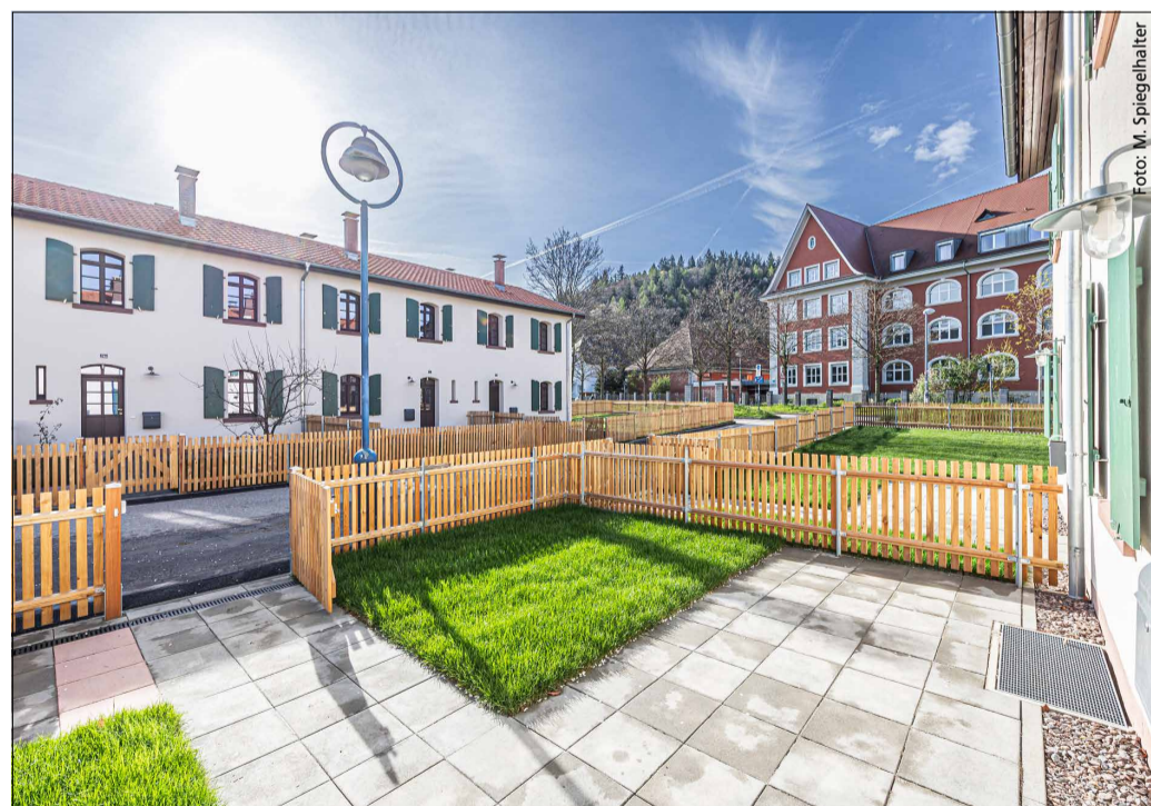
Juwel in der Oberau: Die historische Knopfhäusle-Siedlung erstrahlt in neuem alten Glanz.
