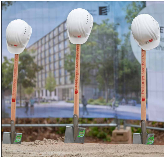
Drei Spaten für ein Halleluja: Rund 59 Millionen Euro investiert die Stadtbau in der Wirthstraße.
