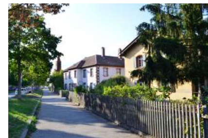
Ansicht Schützenallee von Südosten
