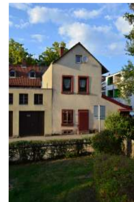
Rückgebäude, Ansicht von Süden
