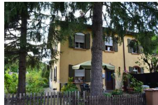
Ansicht von Südosten
