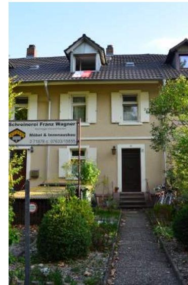
Ansicht von Norden
