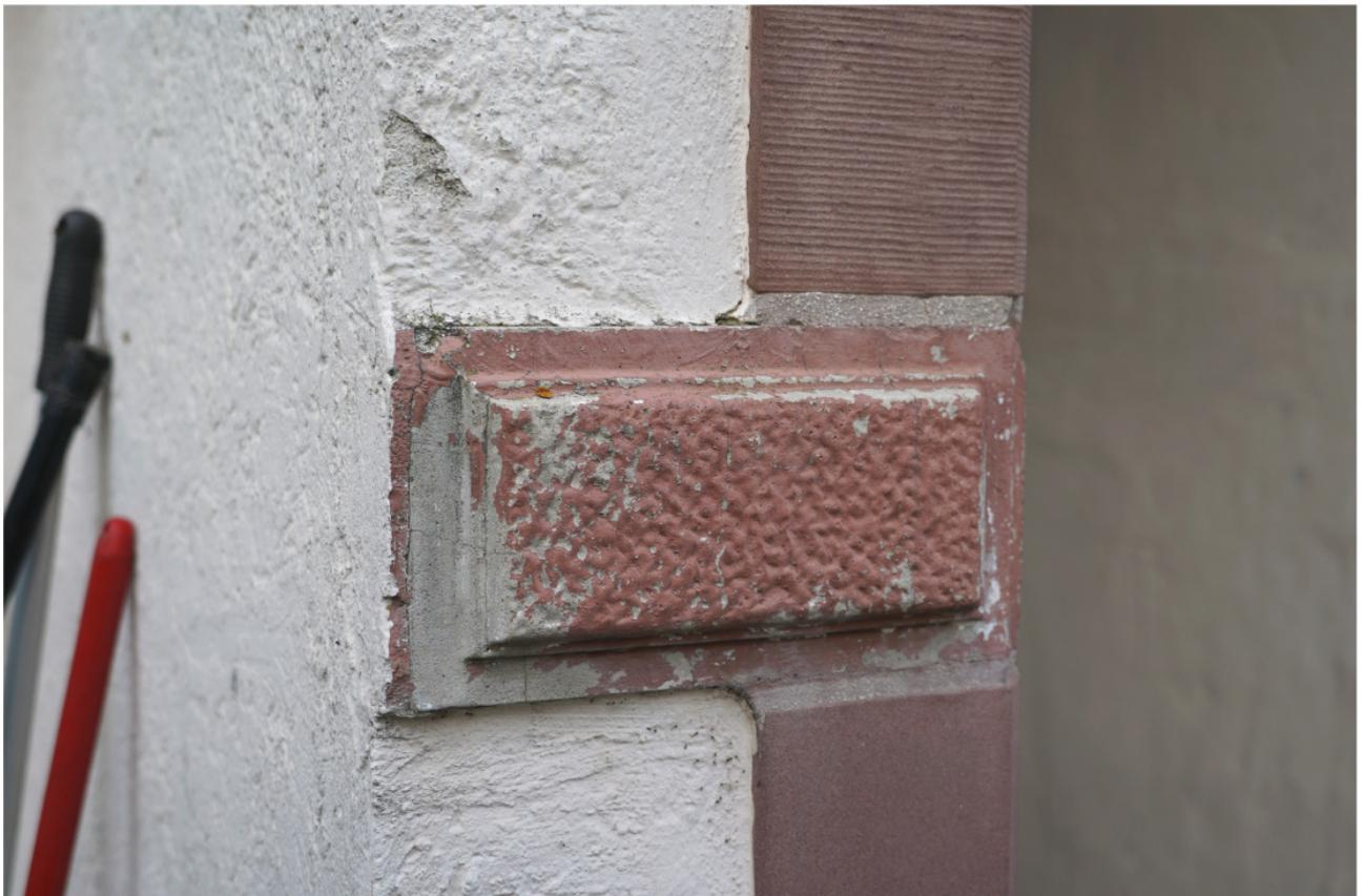
Wie Abb. 1, Einbinder in Form eines Rustikaquaders als Kunststein aus grauer Zementmasse mit sandsteinfarbenem Anstrich **6**
