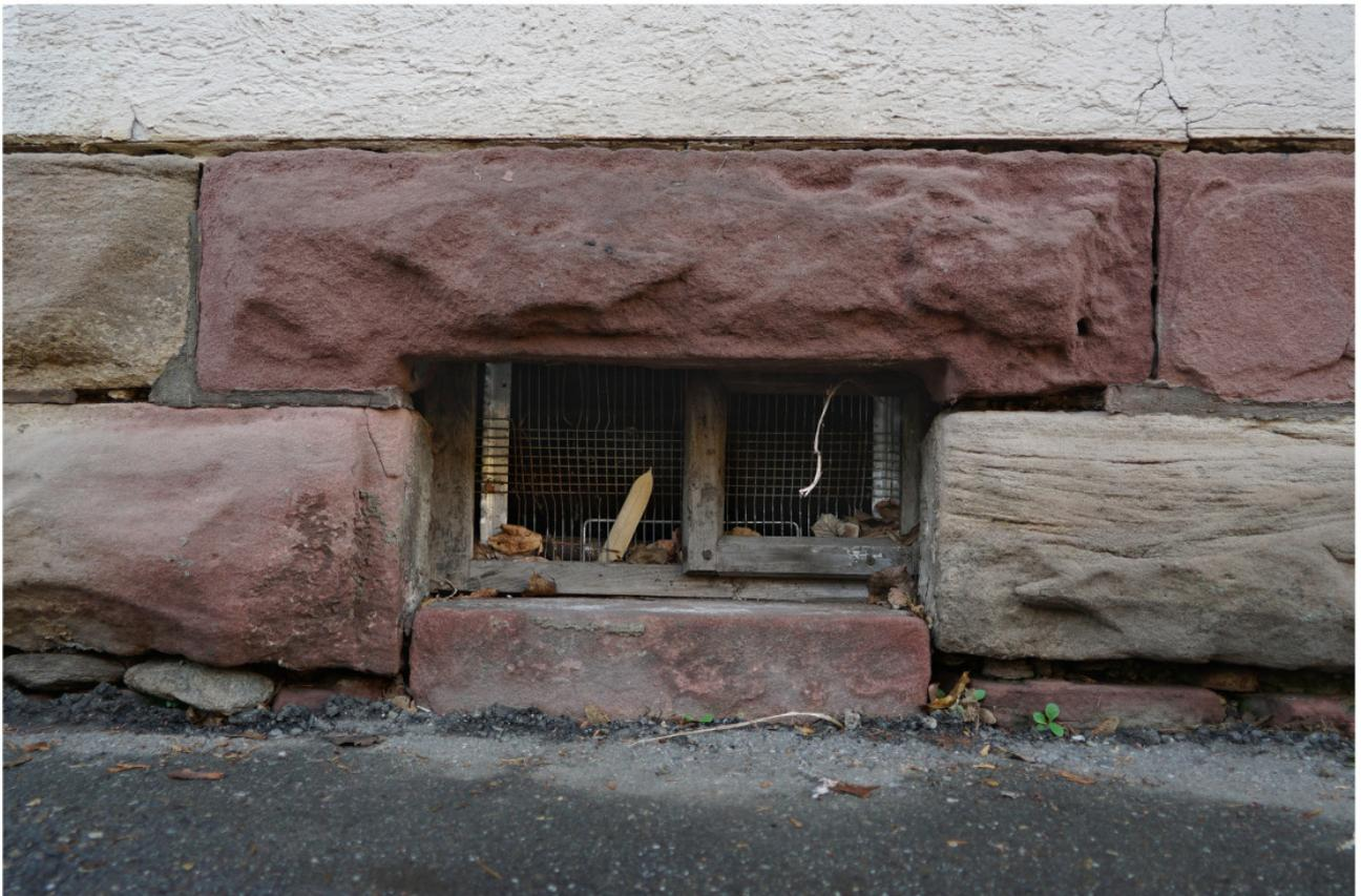
Wie Abb. 7, gedreht eingesetztes Fenster mit nach außen gewandtem Schieber
