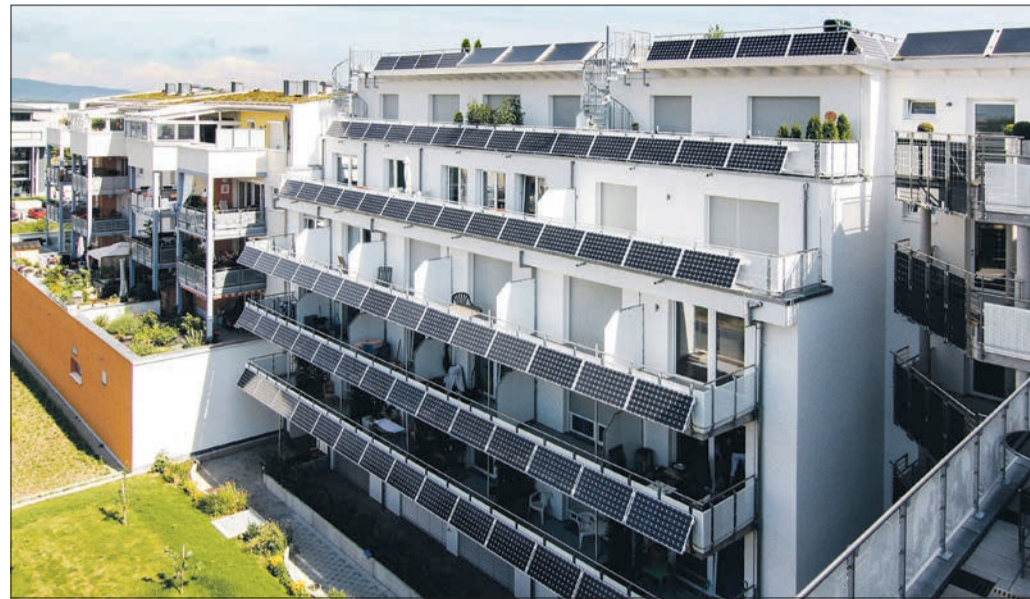
Saftige Rendite: Hier wurden alle Möglichkeiten der Photovoltaik konsequent genutzt. Merke: Nicht nur das Dach kann mehr, auch Balkone haben viel Potenzial. (Foto: A. J. Schmidt)
