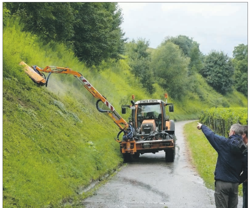
Böschungspflege: Mittels Auslegern werden die Böschungen gemulcht oder gemäht. Beim Mulchen wird die Vegetation bis zum Boden abgeschlagen und zerkleinert. Sollen größere Bäume entfernt werden, sind dagegen Motorsägen erforderlich. (Foto: M. Hollerbach)
