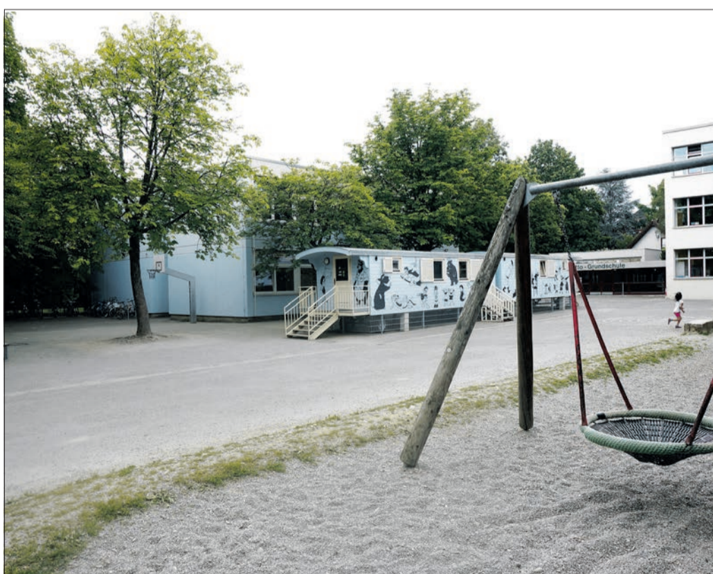
Loretto Schule wächst: Das himmelblaue Bestandsgebäude wird aufgestockt; links davon entsteht ein Erweiterungsbau. Zusammen bieten sie Platz für zehn neue Klassenzimmer. (Foto: A. J. Schmidt)
