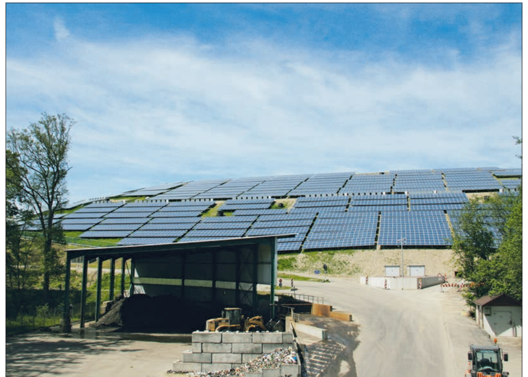
Aus dem ehemaligen „Müllberg“ Eichelbuck ist in den letzten Jahren ein „Energieberg“ mit Biogasgewinnung und Solarmodulen geworden. (Foto: ASF)
