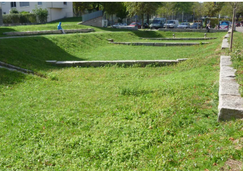
Regenwasserver- sickerungsmulde in der Oberwähre
