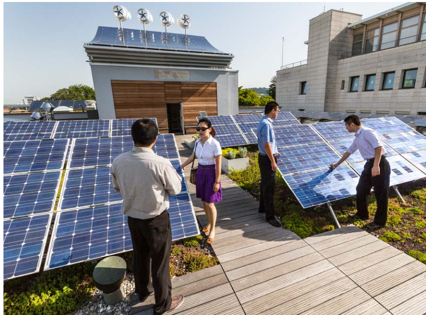
Besichtigung einer Photovoltaikanlage in der Innenstadt
