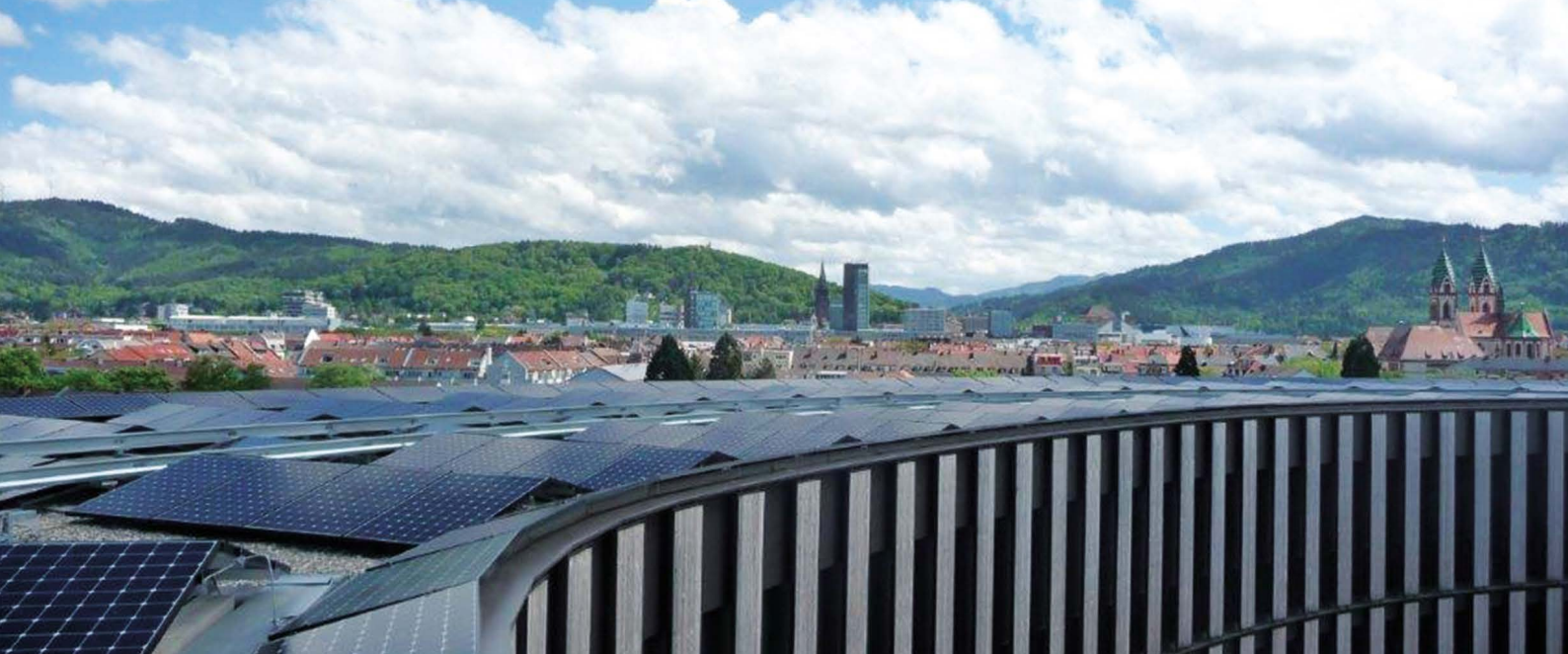
Solaranlage auf dem Dach des Rathauses im Stühlinger
