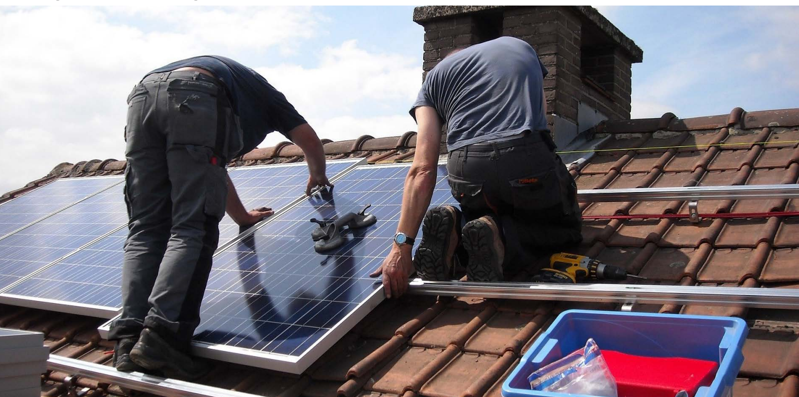
Montage einer Photovoltaikanlage
