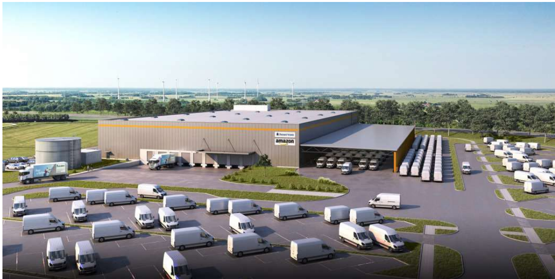
Abbildung 16: Amazon Verteilzentrum - Beispiel für eine Ansiedlung in Ring 3
