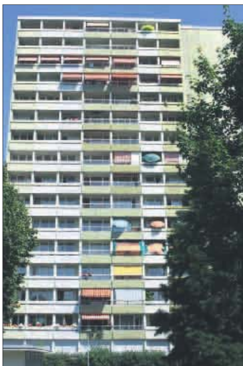
Pilotprojekt: Das 60er-Jahre-Hochhaus in der Bugginger Straße 50 soll zum deutschlandweit ersten Passivhaus umgerüstet werden. Der Heizenergiebedarf sinkt dadurch um fast 80 Prozent (Foto: R. Buhl)
