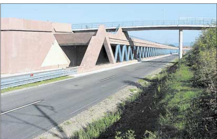
... und so sieht es dort heute nach dem Abschluss der Bauarbeiten tatsächlich aus
