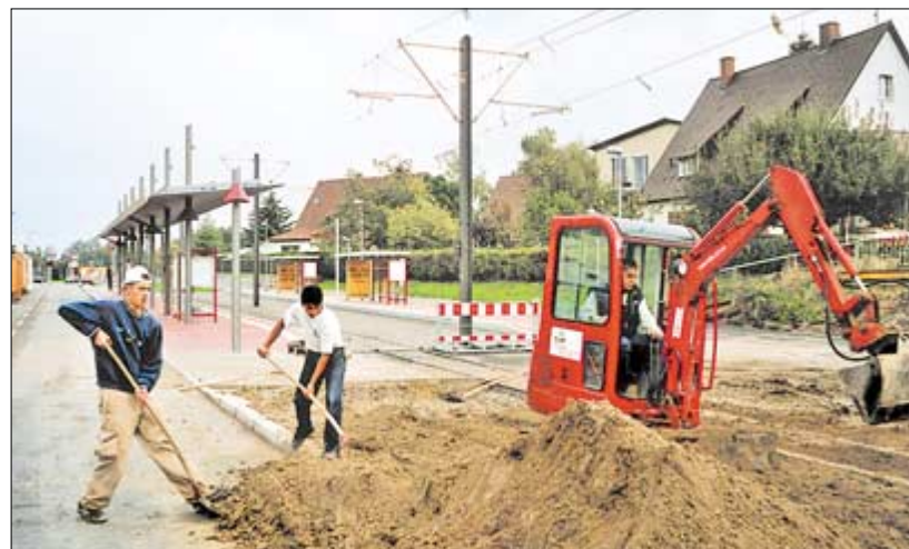
Letzte Arbeiten an der – vorläufigen – Endhaltestelle „Pressehaus“
