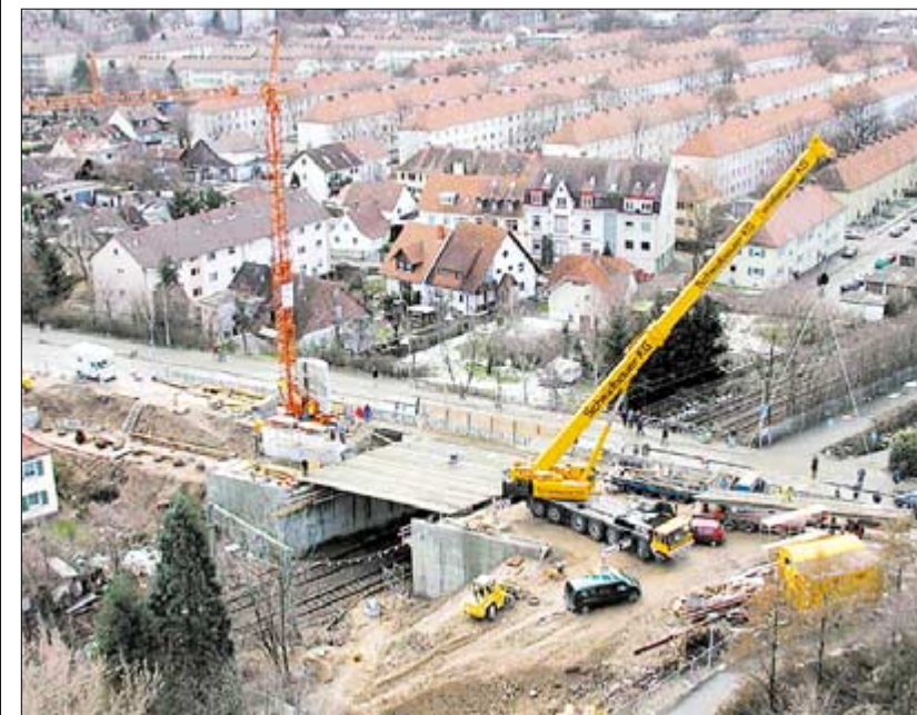
Besonders schwierig gestaltete sich der Brückenschlag über die Güterbahnstrecke zwischen Haslach und Weingarten. Hier soll später auch ein Umsteigepunkt zur Breisgau-S-Bahn entstehen (Foto: VAG)
