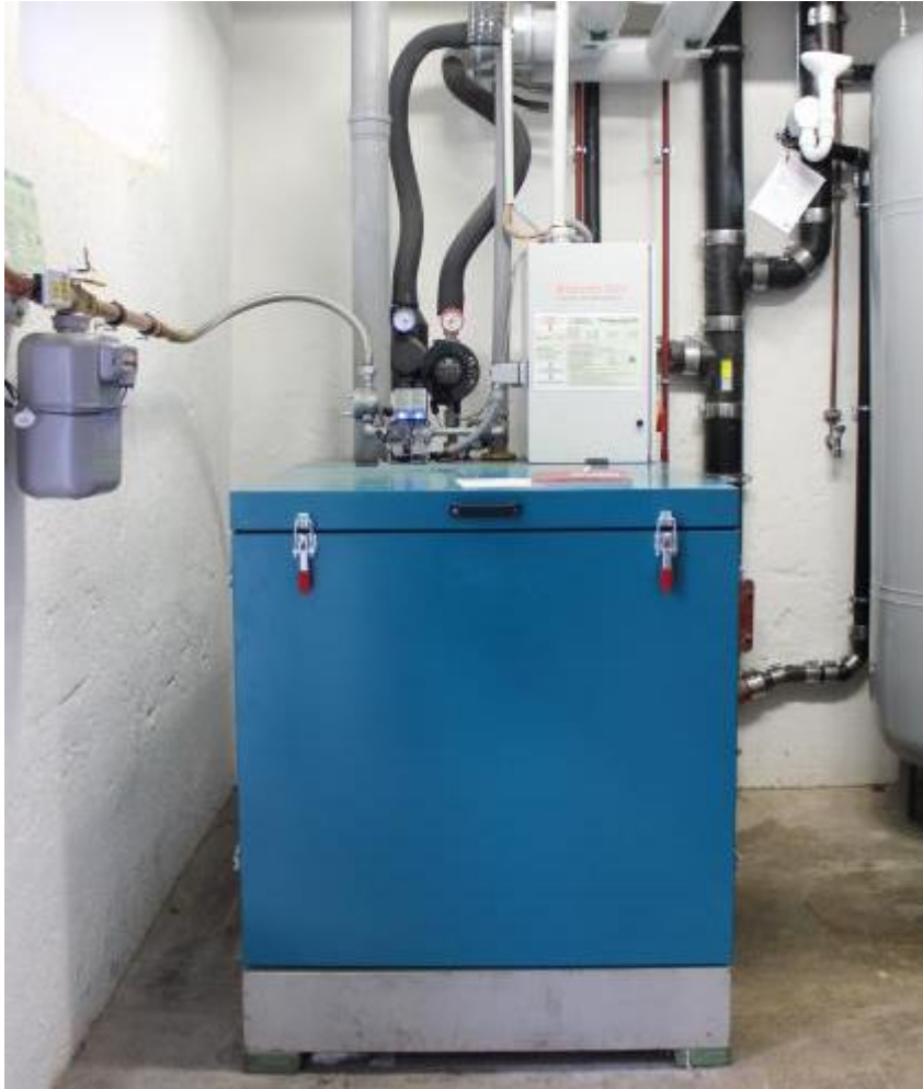
Blockheizkraftwerk und Spitzenlastkessel
