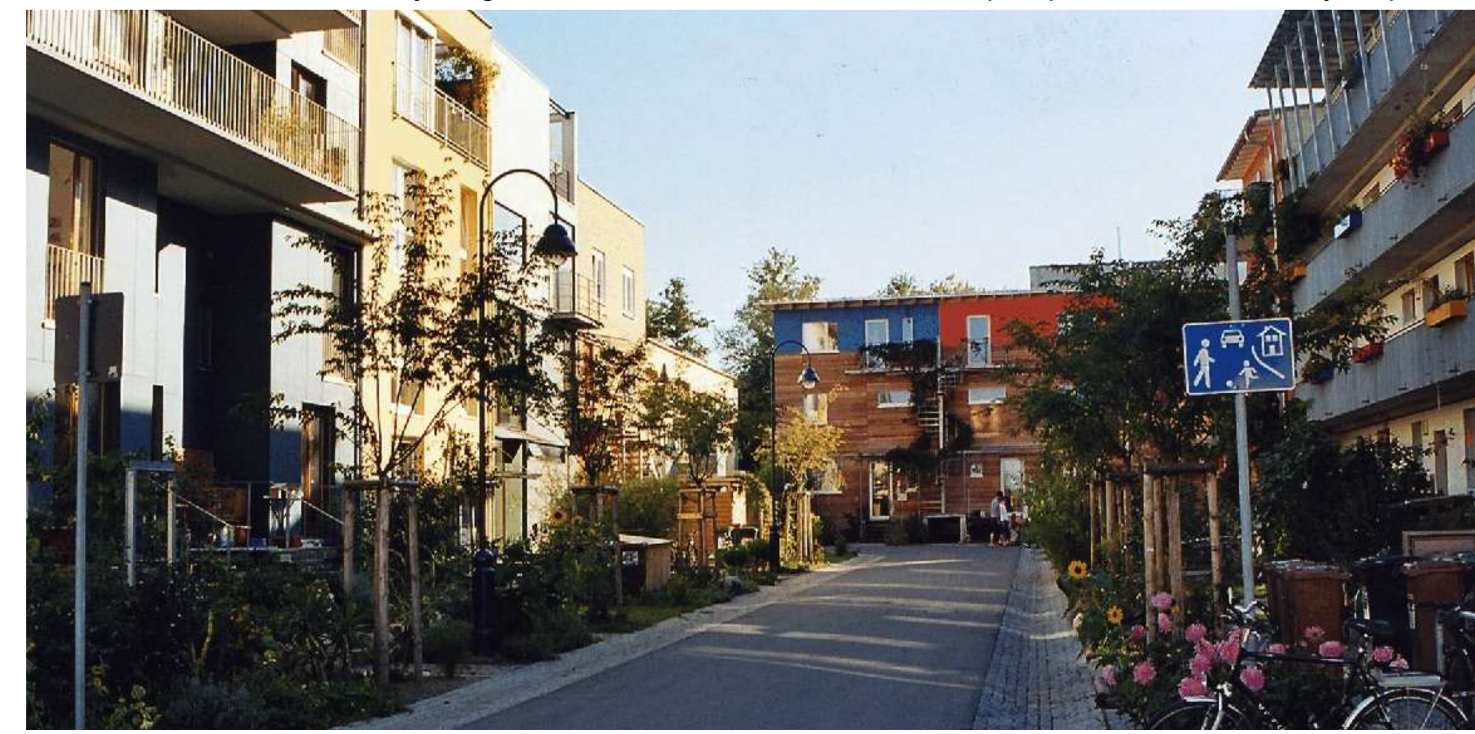
Harriet-Straub-Straße / Verkehrsberuhigter Bereich - Traffic-calmed area
