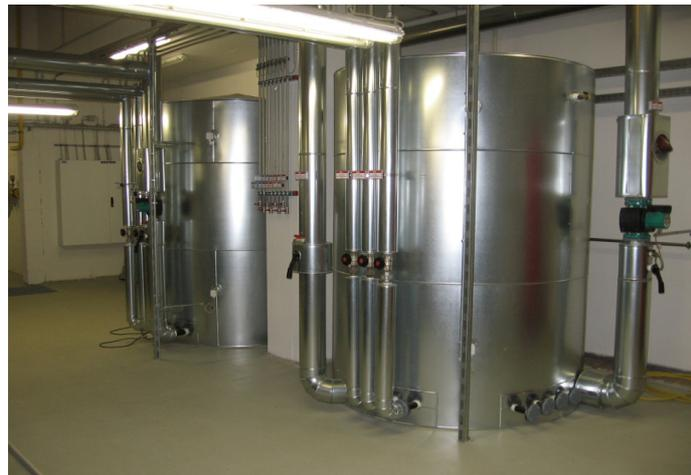
**Abb. 8: Hochwärmegedämmte Pufferspeicher BHKW-Betrieb in den Richard-Fehrenbach- u. Walther-Rathenau-Gewerbeschulen**
