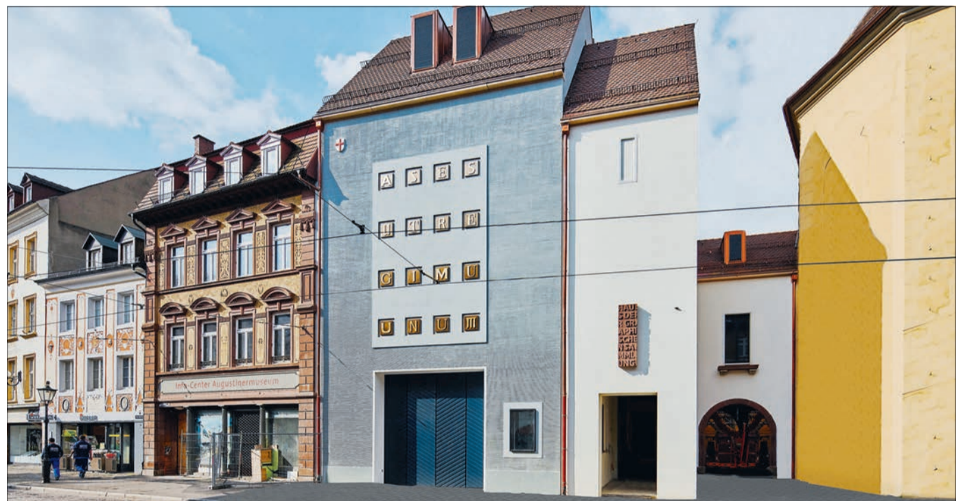
Das Haus der Grafischen Sammlung präsentiert sich kleinteilig und passend zur spätmittelalterlichen Umgebungsbebauung der Salzstraße. Reste der Baustelle wurden retouchiert. (Foto und Bearbeitung: Dilger, Augustinermuseum)
