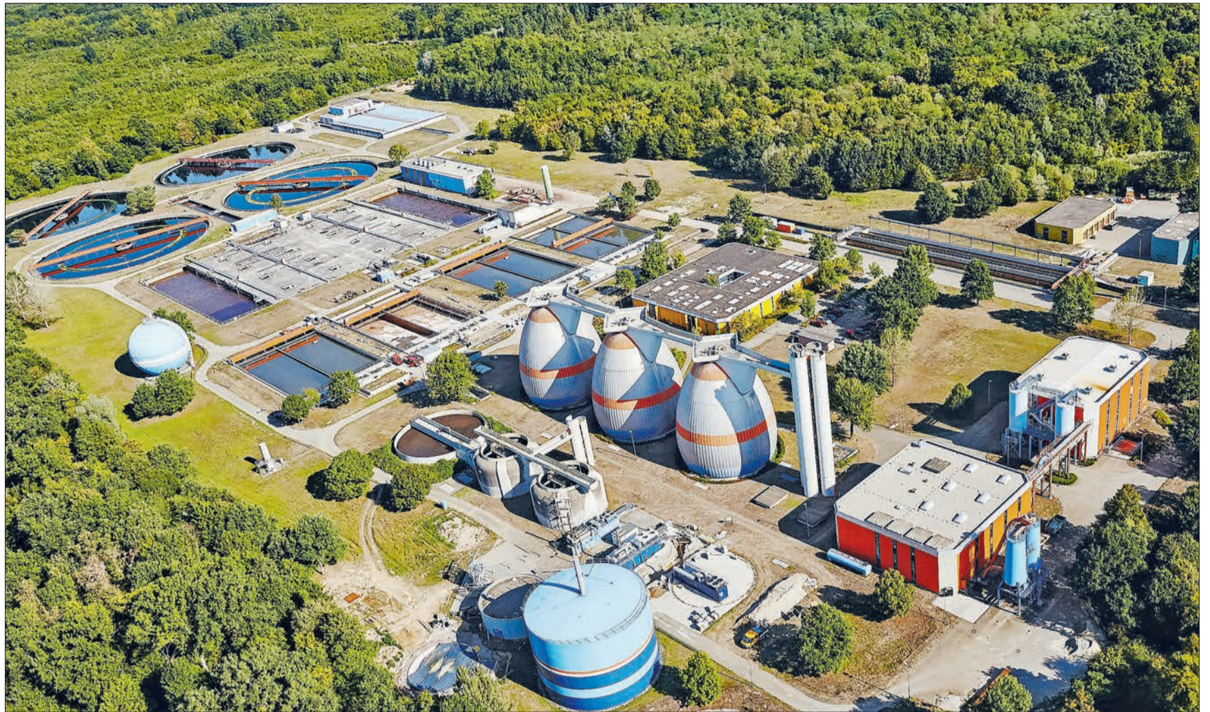
Die Kläranlage im Überblick: Ins Auge fallen zunächst die drei großen Faultürme im Zentrum, in denen der Klärschlamm vergärt. Das entstehende Gas wird in dem großen blauen Niederdruck-Gasbehälter (im Vordergrund) gelagert. In der linken Bildhälfte sind die Vorklärbecken sowie die Belüftungs- und Nachklärbecken (von rechts nach links) erkennbar. Die geplante Erweiterungsfläche liegt im Wald am oberen Bildrand. (Foto: AZV)
