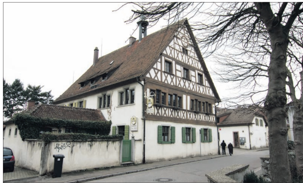
Die Traditionsgaststätte in der St. Georgener Blumenstraße wird saniert und soll Mittelpunkt des geplanten Bürgerzentrums werden. (Foto: A. J. Schmidt)
