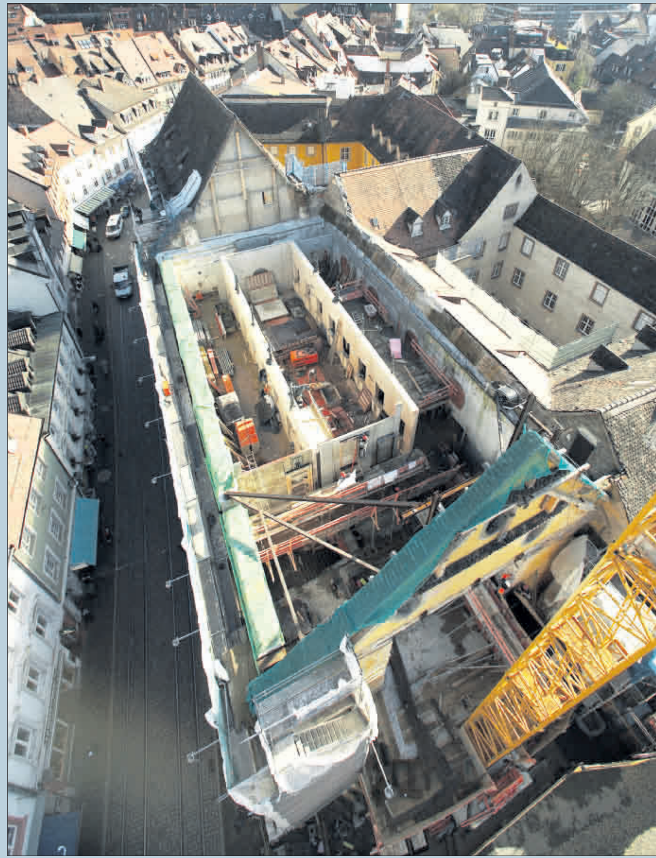
Aus schwindelner Höhe hat sich der Fotograf einen Überblick verschafft: Vorne die Eingangsfront mit dem Foyer, dahinter das offene Kirchenschiff mit dem noch eingedeckten Chor (Foto: F. Bilger)
