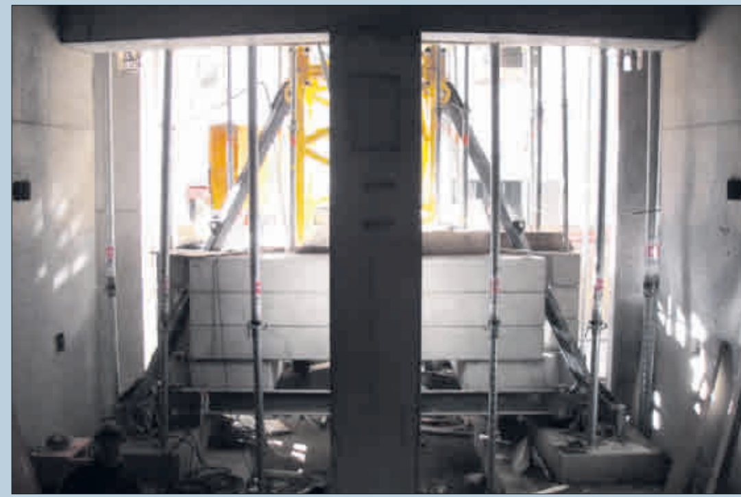
Der zukünftige Eingang von innen. Vor hier aus erschließen Treppen und ein Aufzug die Ausstellungshalle, die Emporen des Kirchenschiffs und die Gemäldeausstellung im Dachgeschoss (Foto: G. Süßbier)
