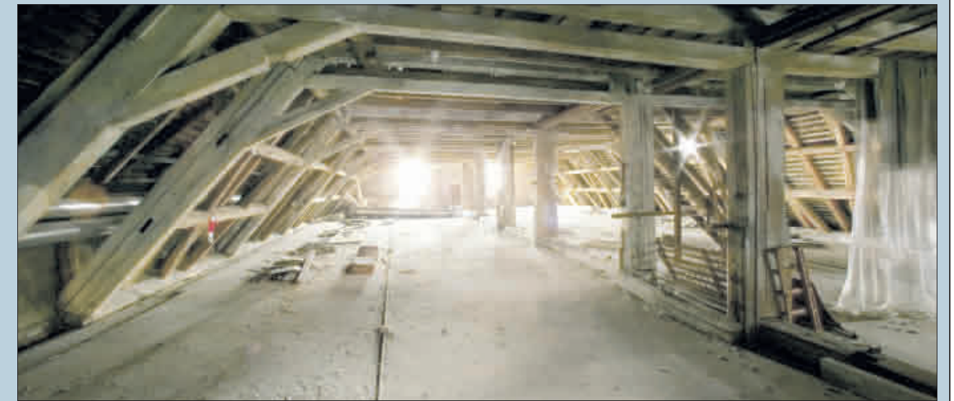
Der denkmalgeschützte Dachstuhl vor Baubeginn. Hier sollen auf 200 Quadratmetern Gemälde des 19. und 20. Jahrhunderts gezeigt werden (Foto: F. Bilger)
