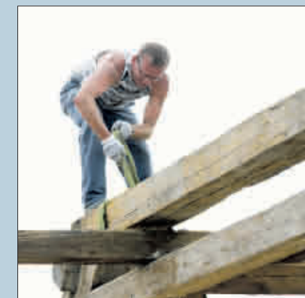
Der Abbau des Dachstuhls war eine große Herausforderung für Spezialisten. Die noch brauchbaren Dachziegel werden zur Zeit im Hof des Kreuzgangs gelagert (Bild rechts) (Fotos: F. Bilger)
