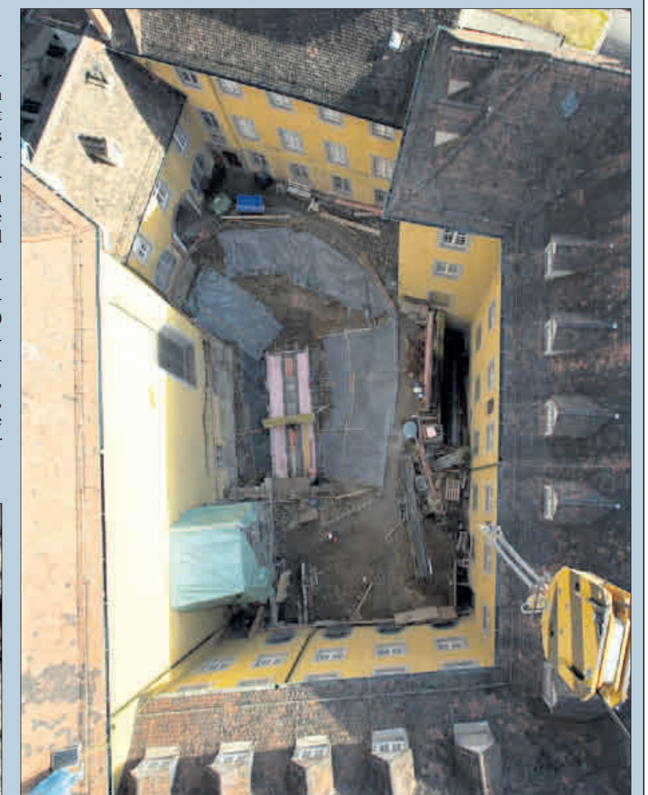
Tiefer Blick in den Osthof: Die beiden Gebäude aus dem 19. Jahrhundert (oben links im Anschluss an den Chor, ganz links) werden im 2. Bauabschnitt abgerissen und durch ein funktionales Gebäude ersetzt, über das auch die Anlieferung erfolgen soll. Das passiert zur Zeit noch mühsam per Hand treppauf und treppab (Foto: F. Bilger)
