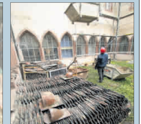
Der Abbau des Dachstuhls war eine große Herausforderung für Spezialisten. Die noch brauchbaren Dachziegel werden zur Zeit im Hof des Kreuzgangs gelagert (Bild rechts) (Fotos: F. Bilger)
