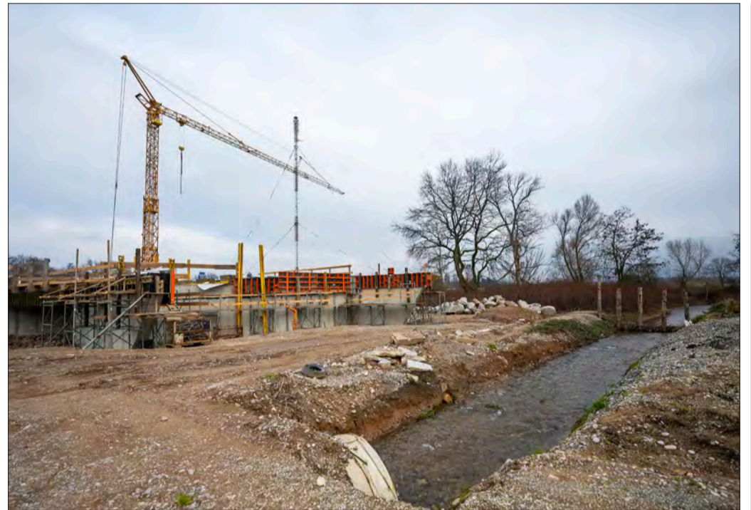
Es geht voran: Über Dietenbach dreht sich schon der erste Kran – für den Gewässerumbau. Das Brückenbauwerk gibt eine Ahnung, wie weit das Gelände aufgeschüttet wird.
