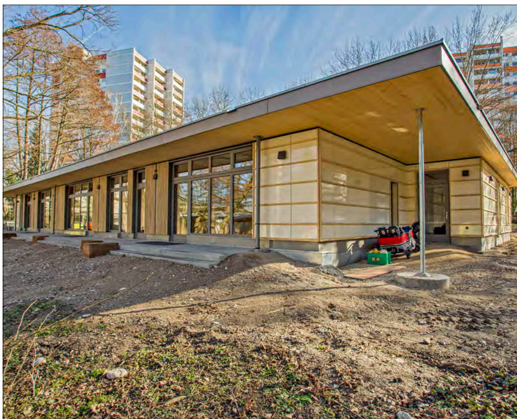
Ein Jahr Bauzeit: Baubeginn war im Januar 2019, im Dezember waren die Arbeiten weitgehend beendet. Die Baukosten für das neue Kita-Gebäude liegen wie geplant und vom Gemeinderat bewilligt bei rund zwei Millionen Euro. (Foto: A. J. Schmidt)
