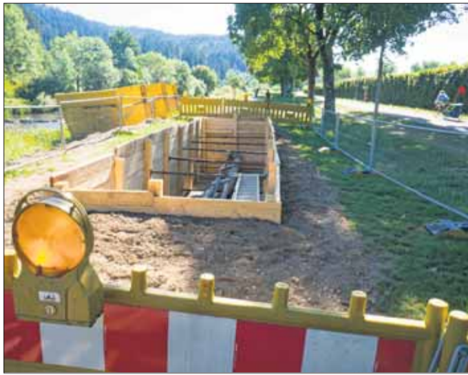
Großes Loch: Entlang der Dreisam erneuert die Badenova das Freiburger Hochspannungsnetz. (Foto: A. J. Schmidt)
