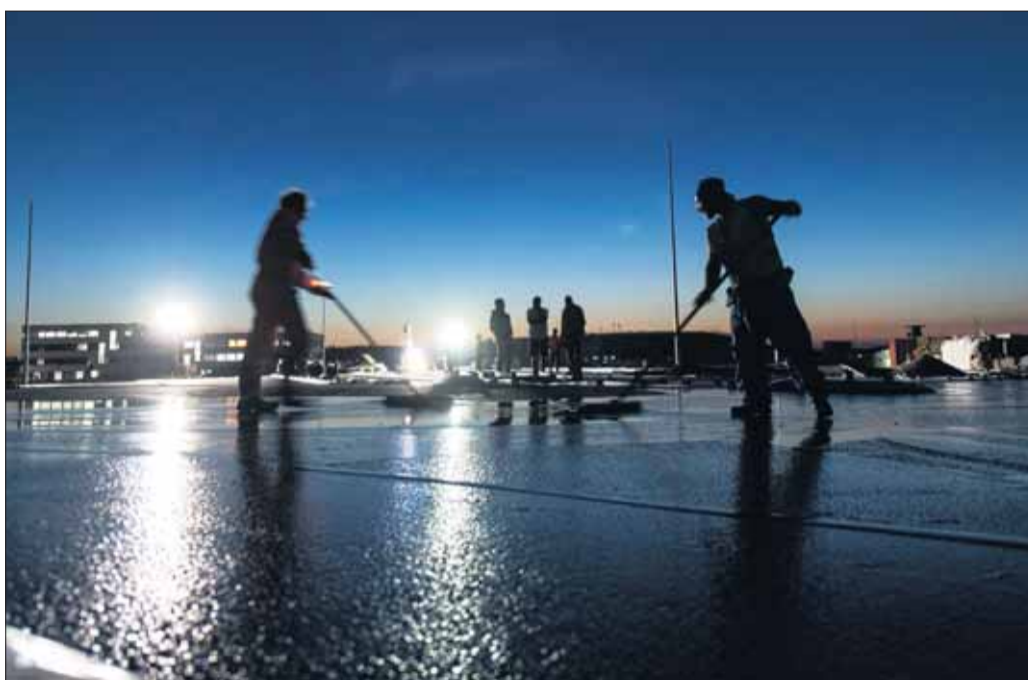
Asphaltballett: Der Belag am neuen Stadion-Busbahnhof wurde vorige Woche zu nächtlicher Stunde aufgetragen. (Foto: P. Seeger)
