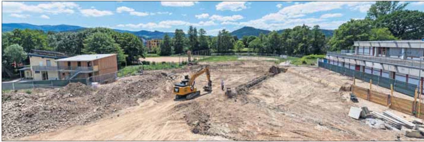
Viel Betrieb: Insgesamt 15 000 Kubikmeter Erde werden im ersten Bauabschnitt ausgehoben. Links ist das inzwischen fertiggestellte „Werki“ zu sehen, rechts die alte Schule. (Foto: P. Seeger)
