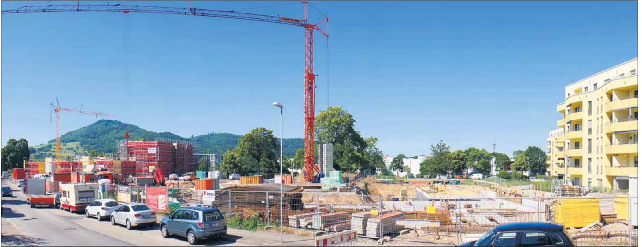
116 neue Mietwohnungen errichtet die Stadtbau zur Zeit auf dem Gelände der ehemaligen ECA-Siedlung in Haslach. 60 von ihnen sind öffentlich gefördert, und alle werden in Holzbauweise fertiggestellt. Links im Bild sind bereits fertiggestellte Mietwohnungsbauten der FSB erkennbar. Nach Wünschen von Verwaltung und Gemeinderat soll der Wohnungsbau der FSB intensiviert werden. (Foto: A. J. Schmidt)
