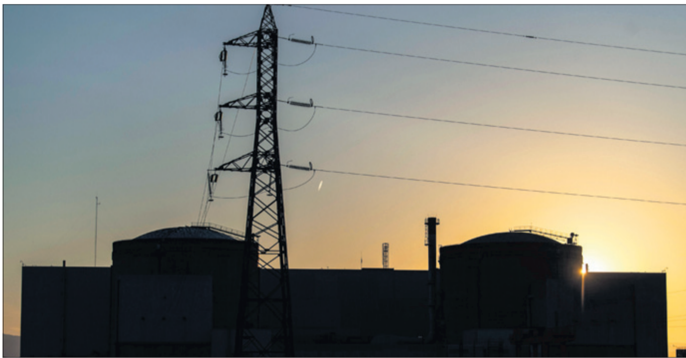
Hinter Fessenheim geht die Sonne unter: Das älteste französische Atomkraftwerk ist nach 43 Betriebsjahren endgültig vom Netz. Jetzt beginnt der Rückbau der Anlage. (Foto: P. Seeger)
