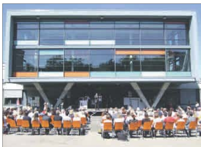
Frisch saniert und für den Ganztagesbetrieb ausgebaut präsentieren sich seit diesem Sommer die Vigeliusschulen in Haslach. Rund 6 Millionen Euro hat der Umbau gekostet. (Foto: R. Buhl)
