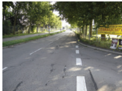
Süd-Ostseite (Blick Richtung Norden)
