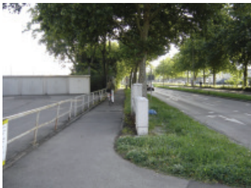
Nord-Westseite (Blick Richtung Norden)
