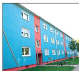
Rislerstraße: Sanierung beendet
