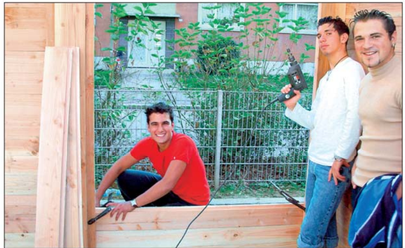
Im Spielplatz Kampffmeyerstraße errichteten Jugendliche und Erwachsene eine Boccia-Bahn sowie das „Teenie-Haus“ (Bild) (Foto: W. Vasen)
