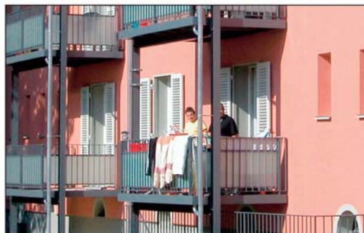
Neues Wohnen in alten Gebäuden: Die Häuser im Nonnenmattenweg erhielten neben Zentralheizungen und neuen Fenstern auch Balkone an der Südwestseite (Foto: E. Heusel)
