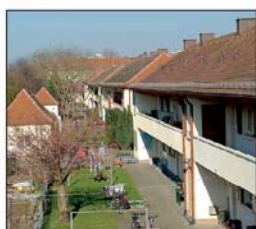
Laubenweg: Abriss und Neubau
