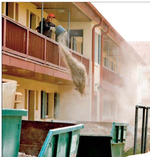
Die Arbeiten im Laubenhof sind in vollem Gang: Wohnungen werden zusammengelegt sowie Bäder und Heizungen eingebaut (Foto: R. Buhl)
