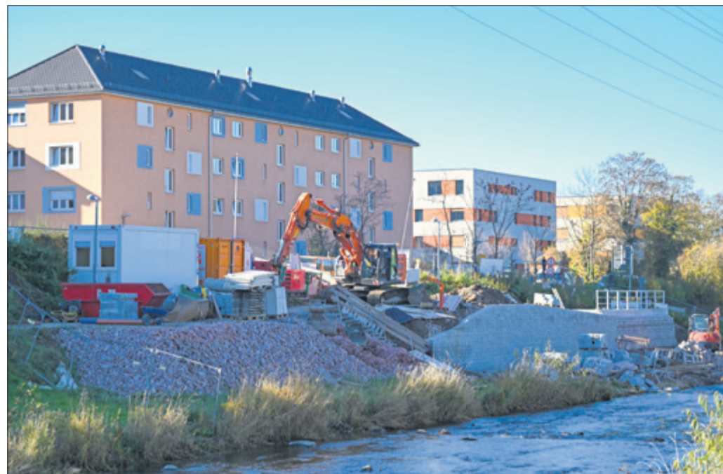
Vier Wochen Vollsperrung: Die Baustelle an der Dreisam unterhalb der Ochsenbrücke wird jetzt zurückgebaut. Dafür ist eine Vollsperrung des Dreisamradweges erforderlich. (Foto: P. Seeger)
