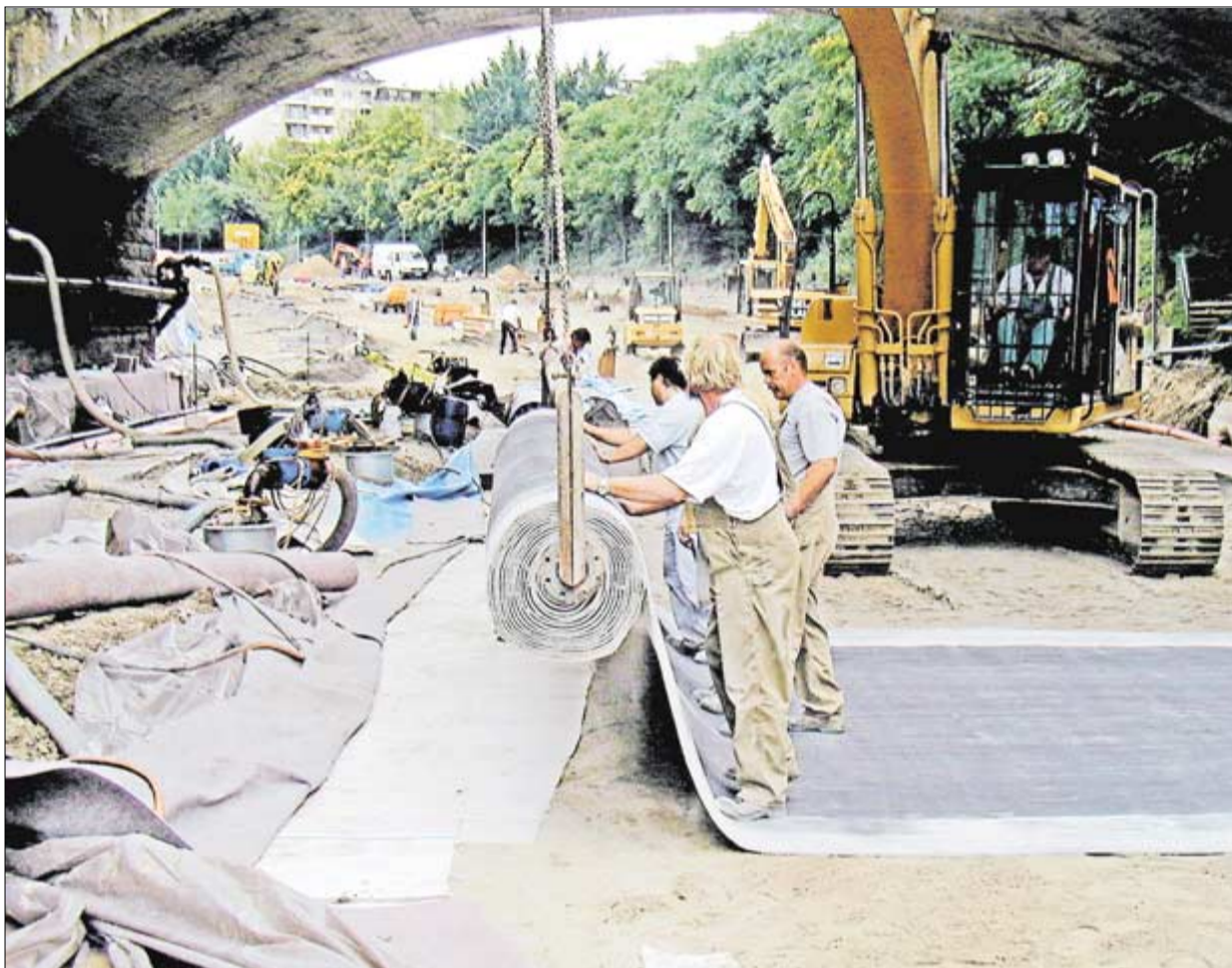
Im Bereich der Bahnbrücken in der Basler Straße mussten Betonmatten eingebaut werden, um die Straße gegen das Grundwasser abzudichten. Die aufwendigen Arbeiten machten im Sommer 2002 eine sechswöchige Vollsperrung dieser Hauptverkehrsstraße erforderlich (Foto: Tiefbauamt)
