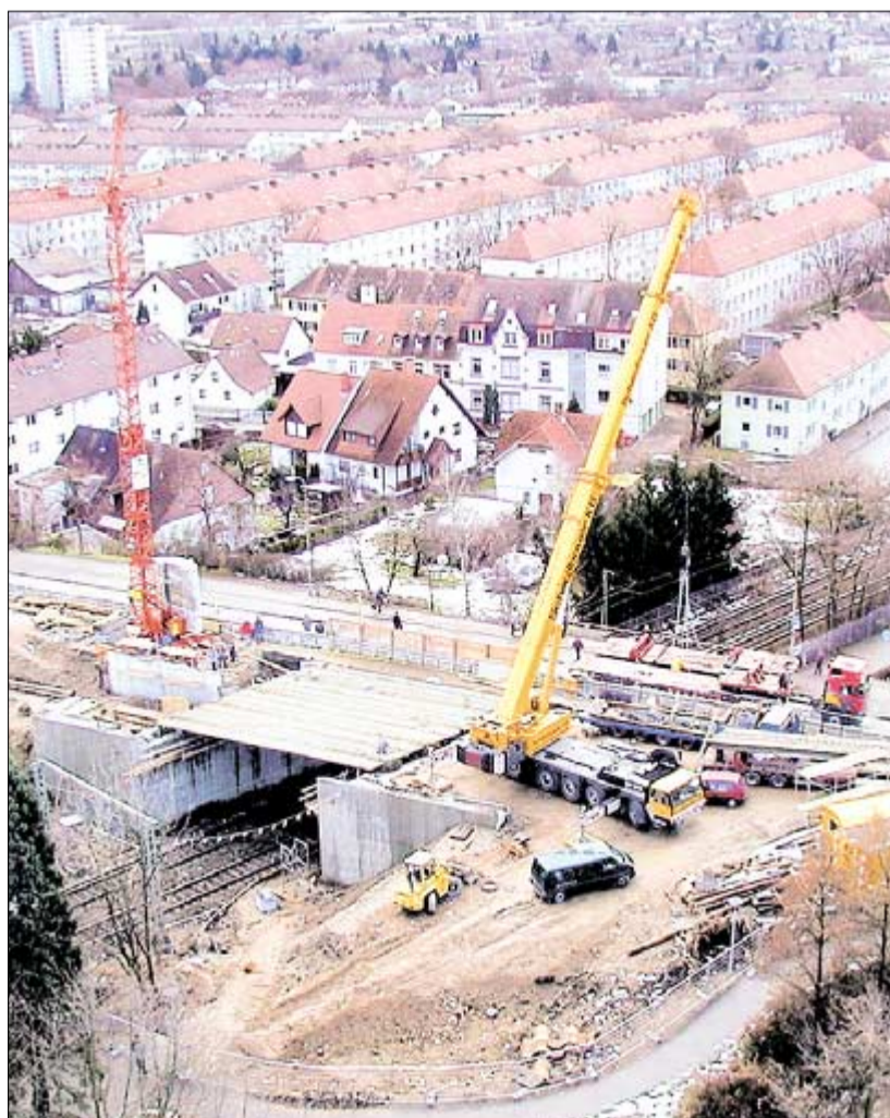
Die Güterbahnbrücke zwischen Haslach und Weingarten wurde erst abgesägt und dann um 15 Meter verbreitert, um Platz für die Stadtbahn zu schaffen. Hier ist auch ein Umsteigepunkt zu der auf der Güterbahntrasse geplanten Breisgau-S-Bahn vorgesehen (Foto: Tiefbauamt)
