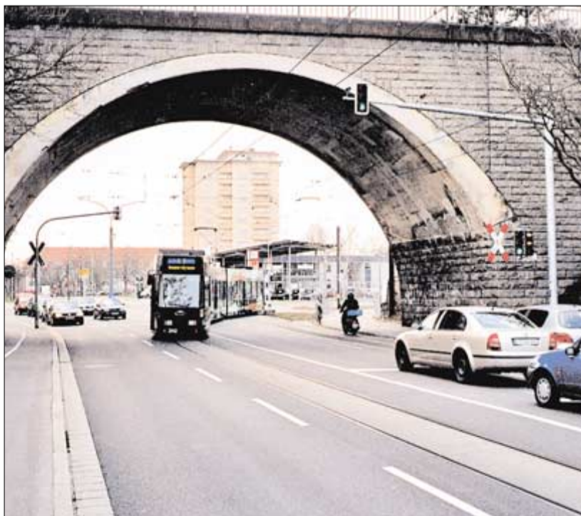
Im Bereich der Bahnbrücken teilen sich Stadtbahn und Kraftverkehr ampelgeregelt den Straßenraum. Dadurch konnte auf eine teure Erweiterung der Bogenbrücke verzichtet werden (Foto: R. Buhl)
