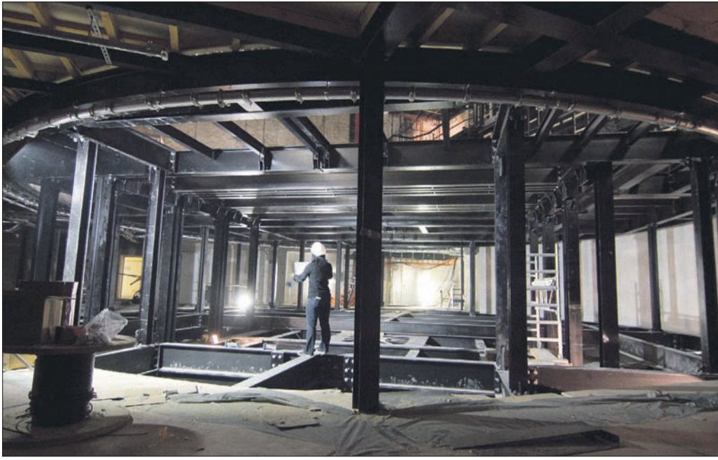
Großbaustelle: Weil im Großen Haus die Bühnentechnik samt Unterbühne komplett erneuert wurde, gastierte das Theater für mehrere Monate auf dem Ganterareal. (Bild: A. J. Schmidt)
