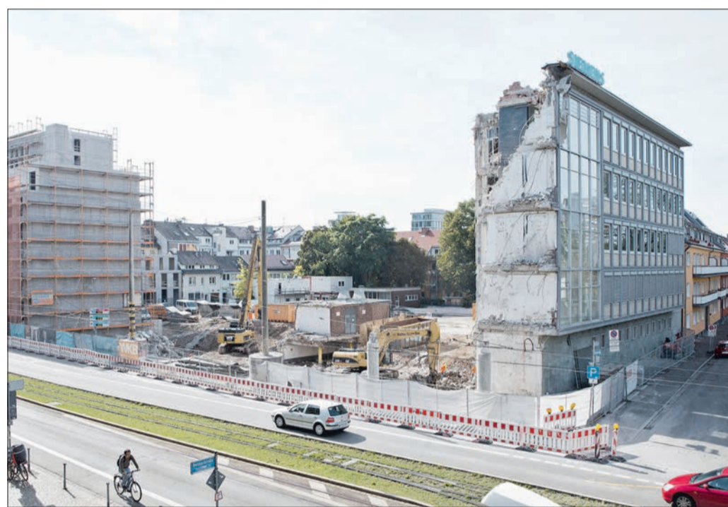
Unverhofftes Potenzial: Im Röderhof an der Habsburgerstraße werden Bürogebäude abgerissen und durch Wohnbauten ersetzt. 340 Wohneinheiten für Studenten und Studentinnen entstehen hier bis 2020. (Foto: A. J. Schmidt)
